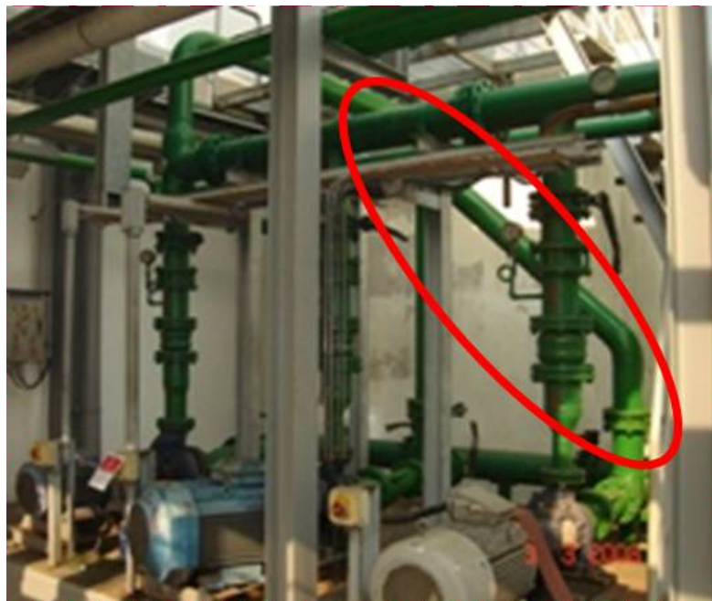
ภาพที่ 5.6-3 ภาพหลังจากการทำการรวมศูนย์ระบบทำความเย็น
