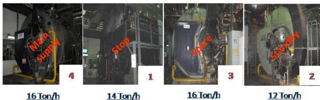
ภาพที่ 5.6-2 ภาพแสดงรูปแบบการเดินเครื่องหม้อไอน้ำแบบใหม่
