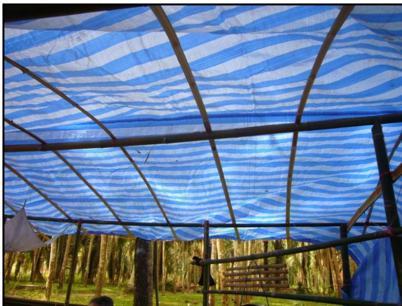
ภาพที่ 47 ลักษณะโครงสร้างหลังคาของโรงกาหลอ
