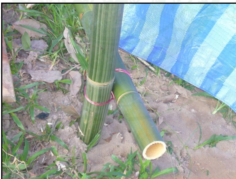
ภาพที่ 46 ลักษณะการผูกเชื่อมต่อโครงสร้างของโรงกาหลอ
