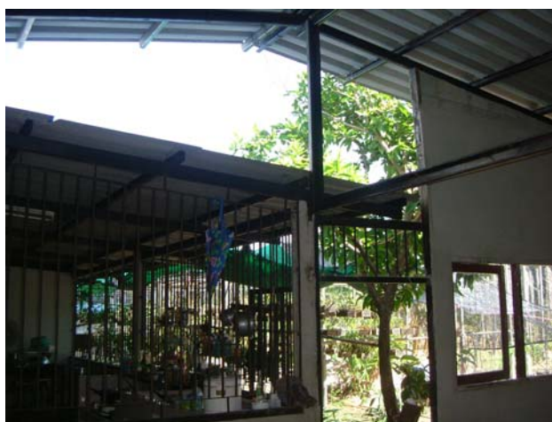
ภาพที่ 14 กลุ่มแม่บ้านเกษตรกรวังหิน: อาคารผลิตเป็นแบบเปิดโล่ง ไม่มีมุ้งลวดป้องกันการปนเปื้อนจากสัตว์และแมลง
