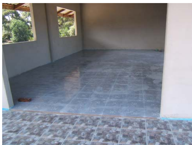
ภาพที่ 53 กลุ่มแม่บ้านเกษตรกรบ้านน้ำโจน: อยู่ในระหว่างการจัดสร้างอาคารผลิต มีการแบ่งแยกอาคารผลิตออกเป็นสัดส่วน โดยจัดทำพื้นและผนังอาคารผลิตให้มีลักษณะเรียบ ไม่มีรอยต่อ ทำให้สะดวกในการทำความสะอาด
