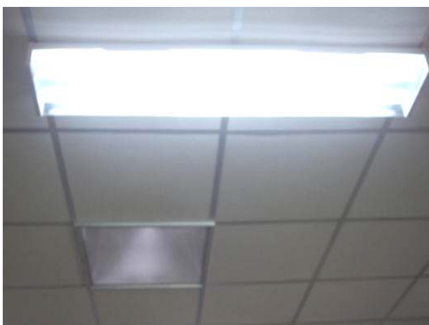
ภาพที่ 57 กลุ่มผู้ผลิตพืชสมุนไพรบ้านเกาะลอย: ทำการติดตั้งหลอดไฟพร้อมฝาครอบหลอดไฟเพิ่มเติมเพื่อเพิ่มแสงสว่างในอาคารผลิตและติดตั้งตัวดูดอากาศเพื่อระบายอากาศและความร้อนที่เกิดขึ้นจากกระบวนการผลิตภายในอาคารผลิต แต่ยังไม่มิตะแกรงป้องกันการปนเปื้อนจากภายนอก
