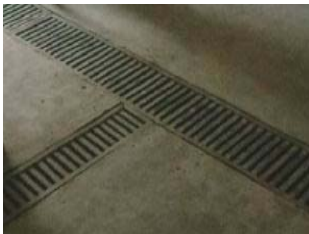
ภาพที่ 50 กลุ่มแปรรูปน้ำสมุนไพร: พื้นอาคารผลิตไม่มีน้ำขังและเนื่องจากมีความลาดเอียงและมีทางระบายน้ำออกนอกอาคารเพื่อระบายน้ำทิ้ง และทางระบายน้ำมีตะแกรงครอบเพื่อป้องกันสัตว์เข้ามาภายในอาคารผลิต
