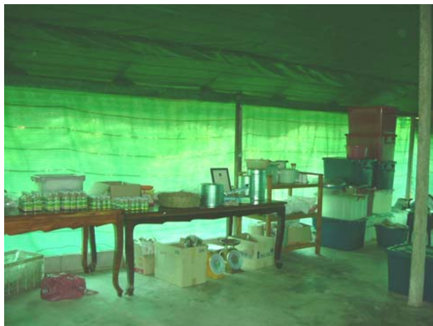
ภาพที่ 9 กลุ่มแม่บ้านเกษตรกรบ้านน้ำโจน: ไม่แบ่งพื้นที่อาคารผลิตออกเป็นสัดส่วน พื้นที่ของอาคารผลิตเป็นพื้นปูน ไม่เรียบ ส่วนผนังอาคารผลิตทำด้วยตาข่าย ทำให้ยากต่อการรักษาความสะอาด
