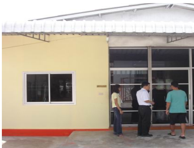
ภาพที่ 49 จ้าบผลไม้แปรรูป: ไม่มีฝุ่นและวัตถุอันตรายทั้งภายนอกและภายในอาคารผลิต เนื่องจากอาคารผลิตเป็นแบบปิด โดยการติดกระจกและมุ้งลวดที่หน้าต่างและประตู
