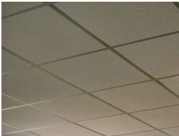
ภาพที่ 13 กลุ่มผู้ผลิตพืชสมุนไพรบ้านเกาะลอย: ภายในอาคารผลิตมีแสงสว่างไม่เพียงพอ และอากาศร้อนเนื่องจากการไม่มีการติดตั้งเครื่องดูดอากาศที่เพดานหรือผนังอาคารผลิตเพื่อระบายอากาศ
