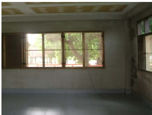
ภาพที่ 52 กลุ่มอาชีพทำกะปิตำบลหนองขี้ม: อาคารผลิตแยกออกจากที่พักอาศัย มีพื้นที่เพียงพอในการผลิต ไม่มีสิ่งของที่ไม่เกี่ยวข้องกับการผลิตในบริเวณผลิต แต่เพดานอาคารผลิตยังไม่เรียบเสี่ยงต่อการปนเปื้อน
