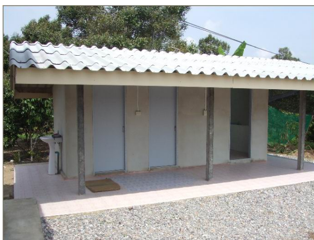
ภาพที่ 73 กลุ่มแม่บ้านเกษตรกรบ้านน้ำโจน: จัดสร้างห้องส้วมแยกจากบริเวณผลิตไม่เปิดเข้าสู่บริเวณผลิตโดยตรง มีมาตรการดูแลความสะอาด มีอ่างล้างมือพร้อมสบู่เหลวและอุปกรณ์ทำให้มือแห้งบริเวณใกล้เคียง แต่ต้องไม่เปิดประตูห้องน้ำทิ้งไว้
