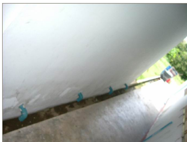
ภาพที่ 51 กลุ่มแม่บ้านเกษตรกรโป่งแรดสามัคคี: มีทางระบายน้ำภายนอกอาคารเพื่อระบายน้ำทิ้งจากกระบวนการผลิต
