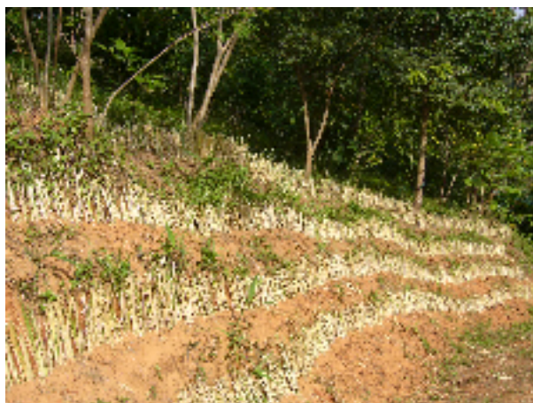
ภาพที่ 4.5 การปลูกหญ้าแฝกเพื่อป้องกันการชะล้างพังทลายของหน้าดิน ที่มา: จากการศึกษา (2549)
