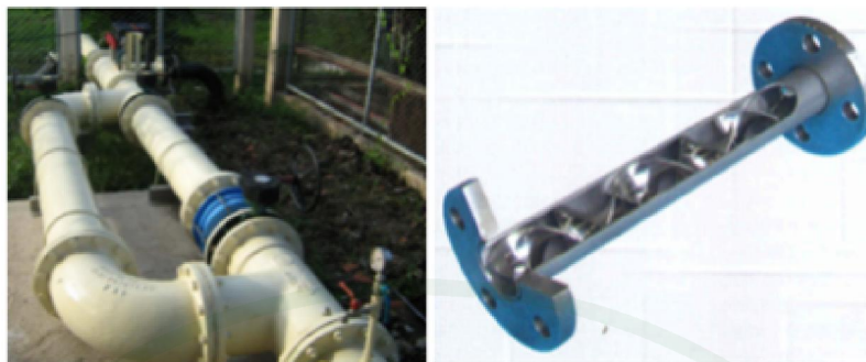
ภาพที่ 6 เครื่องกวนเร็วที่ติดในเส้นท่อ
