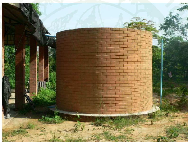
ภาพที่ 16 บล็อกโคงใช้สำหรับก่อสร้างถังเก็บน้ำ
