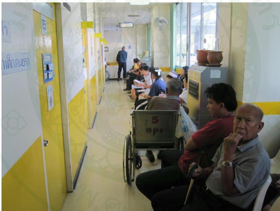
ภาพที่ 32 ช่องทางเดินบริเวณรอบๆไปสู่ทางหนีไฟ
