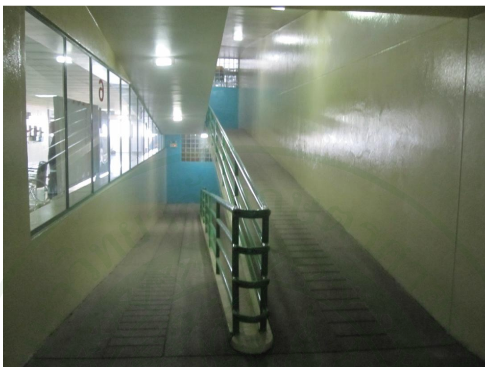
ภาพที่ 33 ทางหนีไฟทางราบ อาคารคุ้มเกล้าโรงพยาบาลภูมิพลอดุลยเดช
