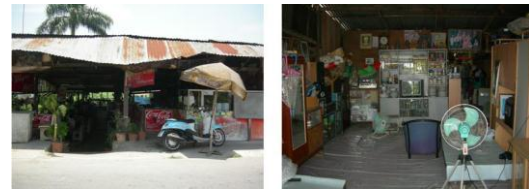
รูปที่ 6 สภาพของที่อยู่อาศัยกลุ่มผู้บุกรุกริมน้ำ ชุมชนศรีวิชัย ประเภทใช้อยู่อาศัยและประกอบพาณิชยกรรม
