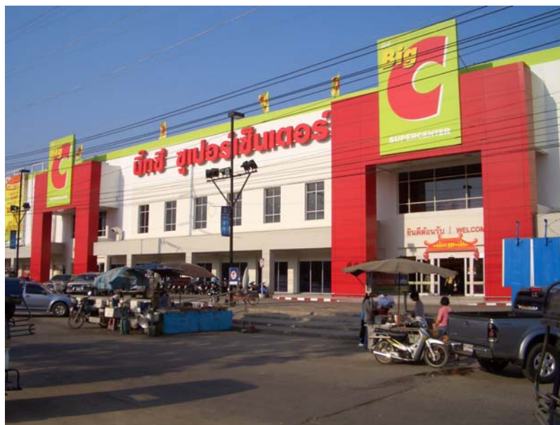
ภาพผนวกที่ จ1 ลักษณะทางกายภาพของพื้นที่จอดรถภายในบริเวณพื้นที่ศึกษาที่ 1. (บิ๊กซี ซูเปอร์เซ็นเตอร์ สาขา จังหวัดเพชรบุรี)
