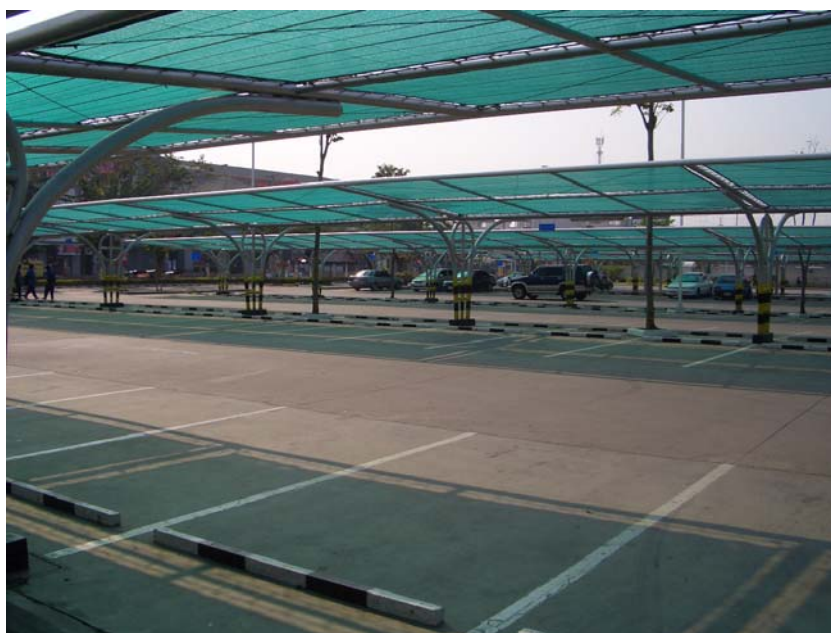
ภาพผนวกที่ จ12 ลักษณะทางกายภาพของพื้นที่จอดรถภายในบริเวณพื้นที่ศึกษาที่ 3. (เทศบาลเมืองสุพรรณบุรี)
