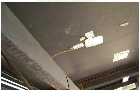
ภาพที่ 23 ตำแหน่งการติดตั้งสายเทอร์โมคัปเปิลบริเวณด้านหลังแผงเซลล์แสงอาทิตย์
