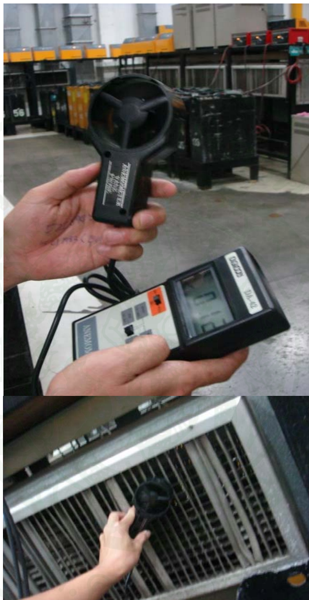
ภาพที่ 52 การตรวจวัดอัตราการไหลของอากาศ
