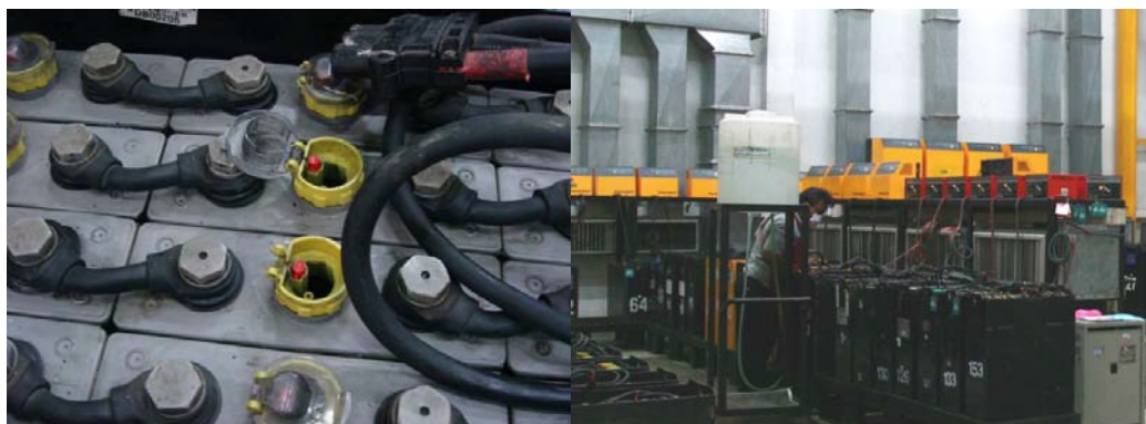
ภาพที่ 25 พนักงานเติมน้ำกลั่นและทำความสะอาดแบตเตอรี่
