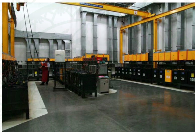
ภาพที่ 2 ห้องประจุไฟแบตเตอรี่ของศูนย์กระจายสินค้า
