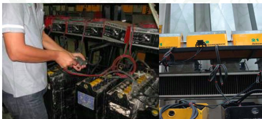
ภาพที่ 26 พนักงานเสียบปลั๊กเพื่อประจุแบตเตอรี่
