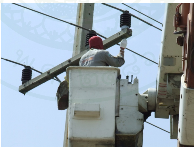
ภาพที่ 28 การนำลูกถ้วยลงจากเสา
