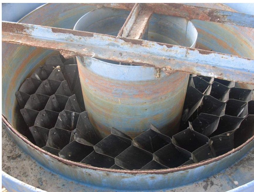
ภาพที่ 6 แผ่นเอียงติดตั้งภายในถังแอน็อกซิก
