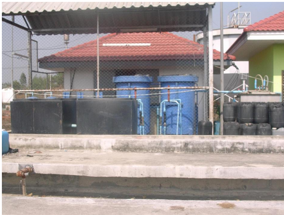
ภาพที่ 5 การติดตั้งระบบถังปฏิกรณ์เชื้อกรองเมมเบรนแบบสองชั้น
