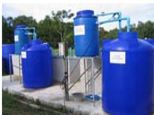
ภาพที่ 16 ถังเก็บน้ำ ถังปรับระดับน้ำ
