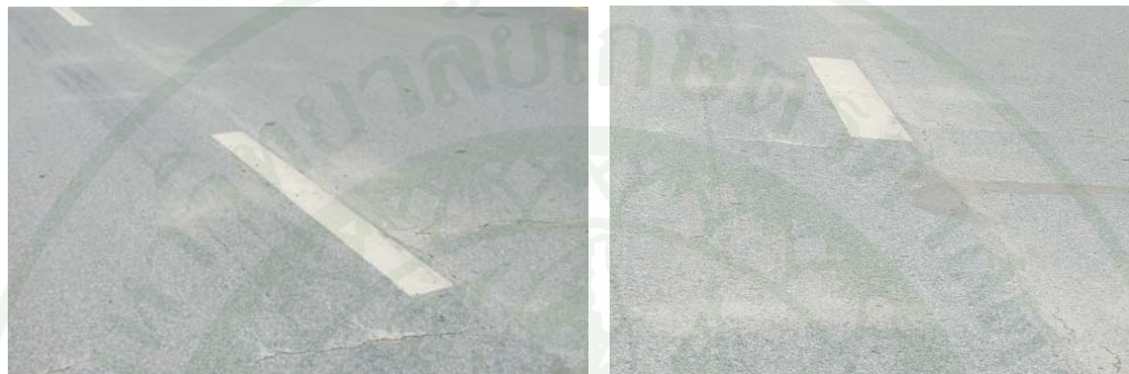
ภาพที่ 47 รอยแตกขนาดเล็กบนผิวทาง
