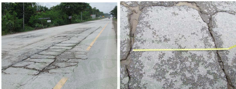
ภาพที่ 1 การแตกร้าวของผิวทางที่มีวัสดุผสมซีเมนต์เป็นชั้นพื้นทาง
