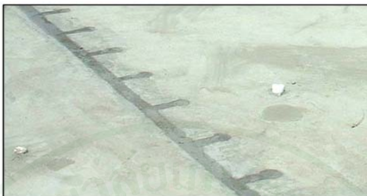
ภาพที่ 73 แนวรอยต่อของแผ่น Kwik Slab ที่เกรท์เสร็จแล้ว
