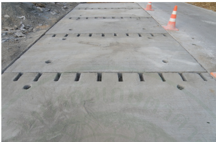
ภาพที่ 148 ภายหลังการติดตั้งแผ่นคอนกรีตสำเร็จรูปเรียบร้อย
