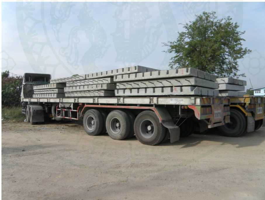
ภาพที่ 131 การขนส่งแผ่นคอนกรีตมาที่แปลงทดสอบ
