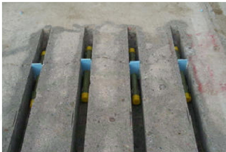
ภาพที่ 31 การซ่อมถนนคอนกรีตด้วยวิธีถ่ายน้ำหนัก (มนัส, 2550)
