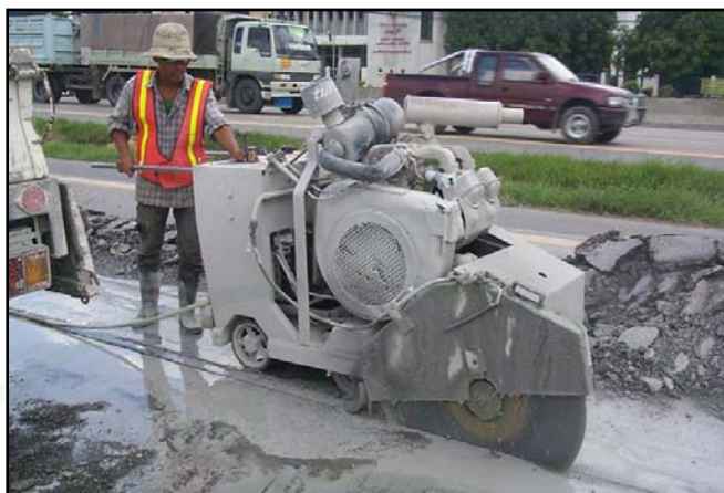
ภาพที่ 41 แยกพื้นที่ที่จะทำการซ่อมแซมด้วยวิธีการใช้เลื่อยตัดคอนกรีต
