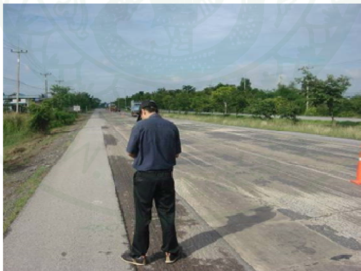
ภาพที่ 13 การตรวจสอบความเสียหายของถนนด้วยตาเปล่า (ชั้นวินและอภิสิทธิ์, 2553)
