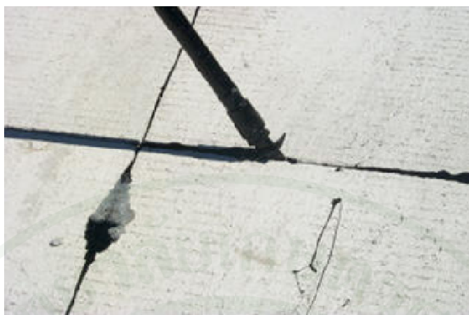
ภาพที่ 30 การซ่อมถนนคอนกรีตด้วยวิธีการเปลี่ยนวัสดุารอยต่อชนิดเทรื่อน (มนัส, 2550)
