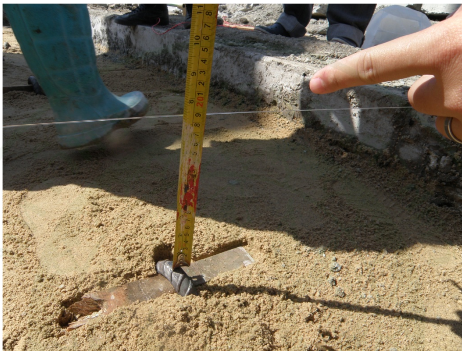
ภาพที่ 143 ตรวจวัดระดับหลังการตอกเข็มเหล็กค้ำรูปตัวยู
