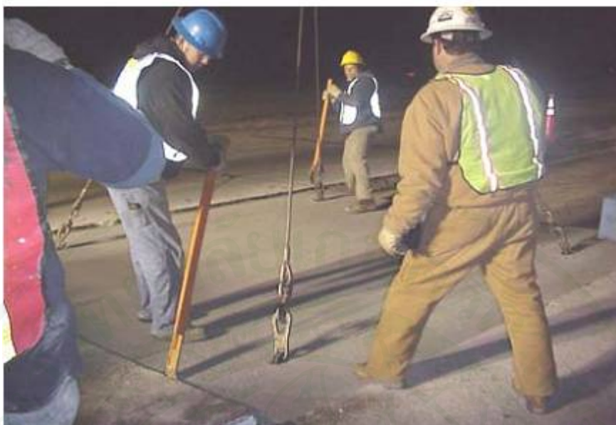
ภาพที่ 63 การติดตั้งแผ่นคอนกรีตก่อนอัดฉีดโฟม (FHWA, 2007)
