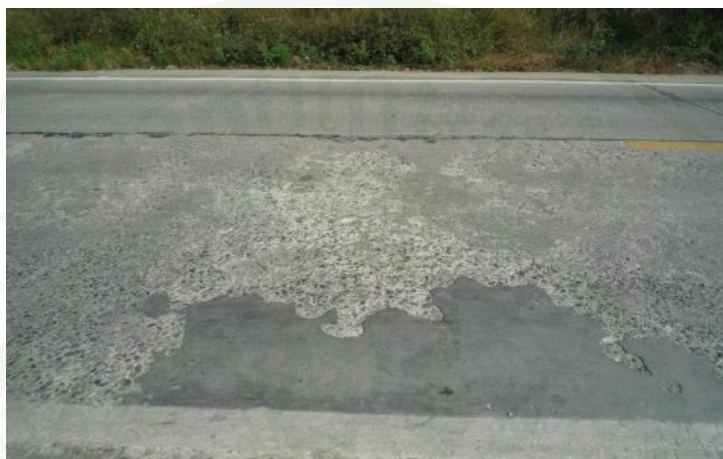
ภาพที่ 7 ผิวมวลรวมถูกขัดสีเป็นมัน (Polished Aggregate)
