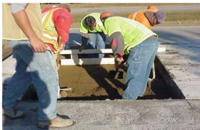
ภาพที่ 50 การทำความสะอาดและเตรียมปรับพื้นที่ใต้พื้นคอนกรีต (FHWA, 2007)
