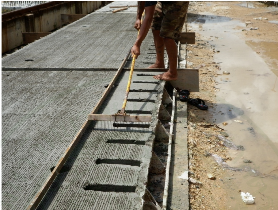
ภาพที่ 128 การชุบผิวหน้าแผ่นคอนกรีต
