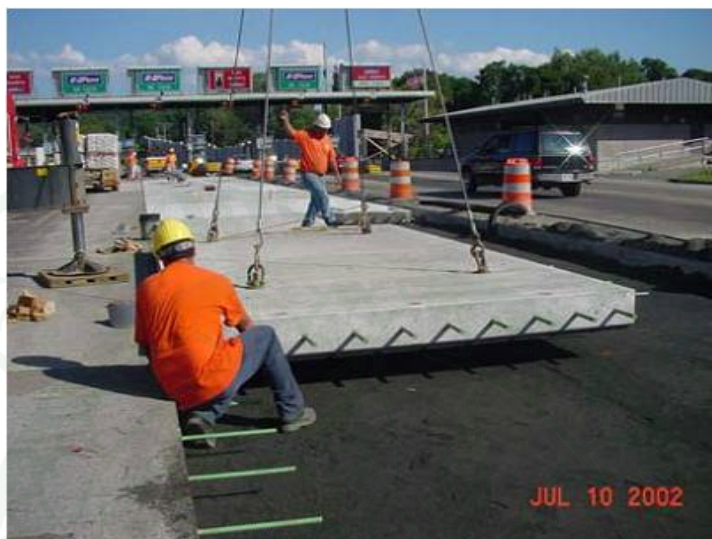
ภาพที่ 78 การติดตั้งแผ่นคอนกรีต (Tayabji, 2008)
