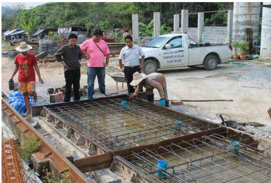
ภาพที่ 122 การเตรียมแบบหล่อแผ่นคอนกรีตสำเร็จรูป
