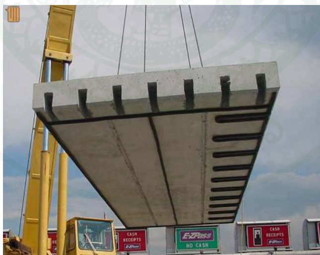
ภาพที่ 77 การติดตั้งแผ่นพื้น Super Slab โดยใช้เครนติดตั้ง (Lacoss, 2008)
