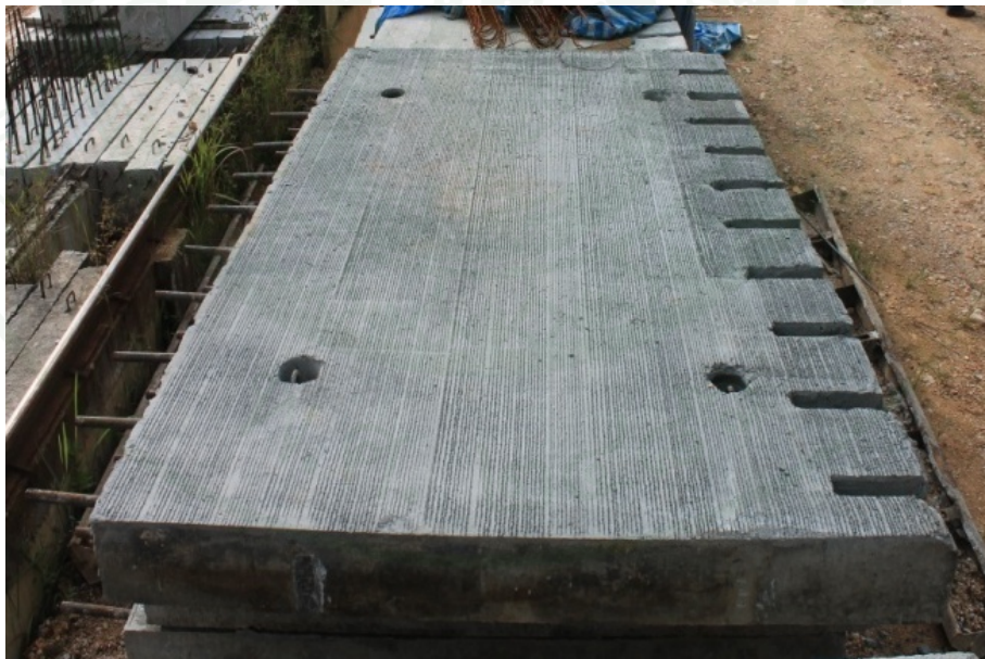
ภาพที่ 129 ลักษณะแผ่นคอนกรีตสำเร็จรูป
