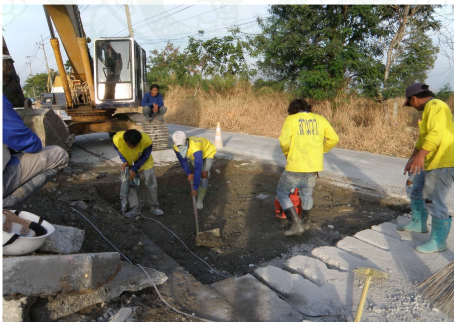
ภาพที่ 139 ทำการขุดชั้นรองพื้นทางออก
