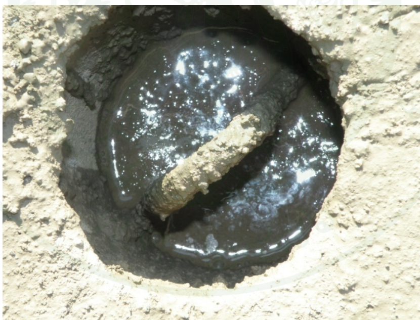
ภาพที่ 151 Self Leveling Mortar เติมเต็มช่องว่างใต้แผ่นคอนกรีตสำเร็จรูป
