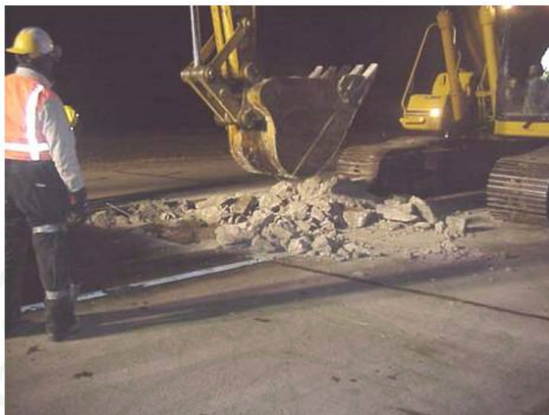
ข.) การใช้รถขุดรื้อแผ่นคอนกรีต
