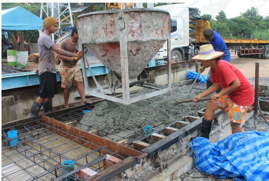
ภาพที่ 123 การเทคอนกรีต
