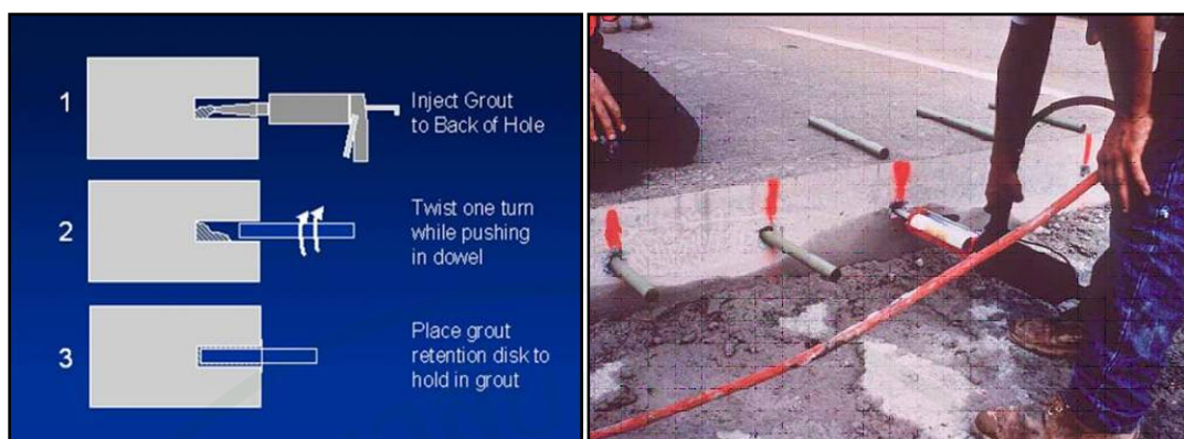
ภาพที่ 43 ติดตั้งเหล็กเคียว
