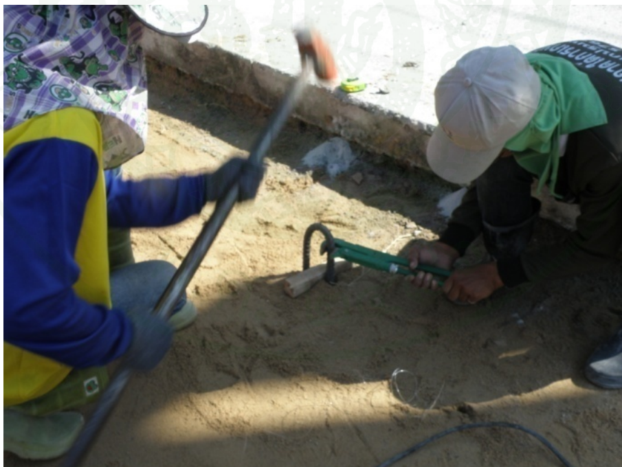
ภาพที่ 142 ตอกเข็มเหล็กค้ำรูปตัวยู
