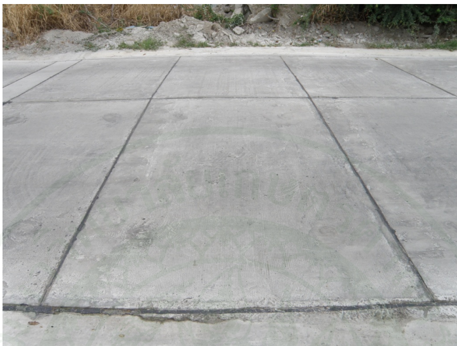
ภาพที่ 161 สภาพรอยต่อถนนภายหลังการซ่อมแซม
