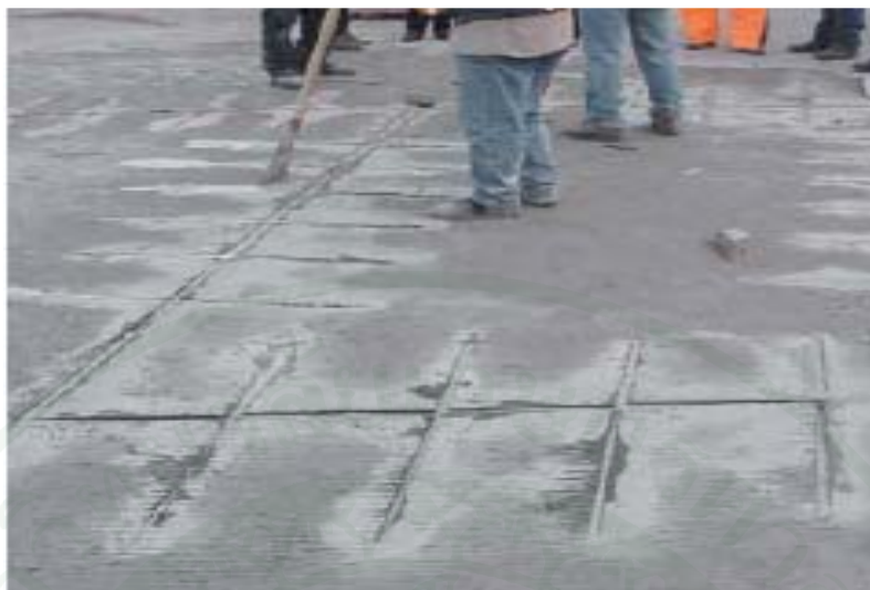
ข) การติดตั้ง Fiberglass ทั้งรอยต่อตามขวาง และรอยต่อตามยาว
