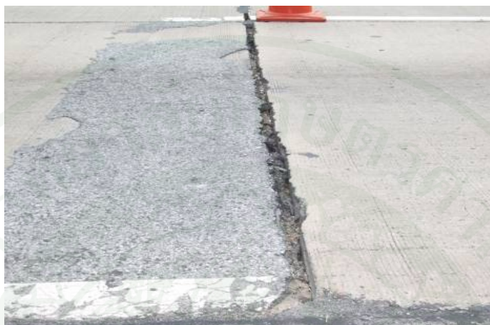
ภาพที่ 6 ความเสียหายของวัสดุยาแนวรอยต่อ
