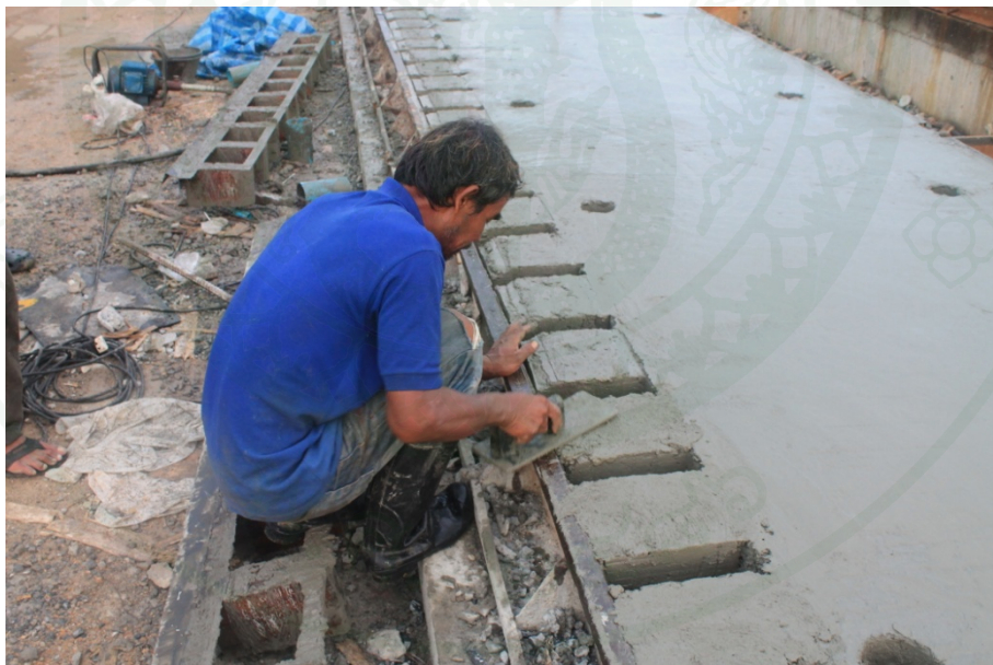
ภาพที่ 127 การแต่งผิวคอนกรีตภายหลังการถอดบล็อกเข้าที่
