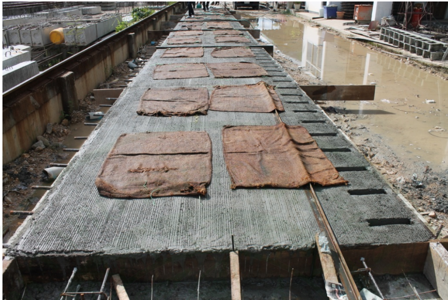
ภาพที่ 130 การบ่มแผ่นคอนกรีต
