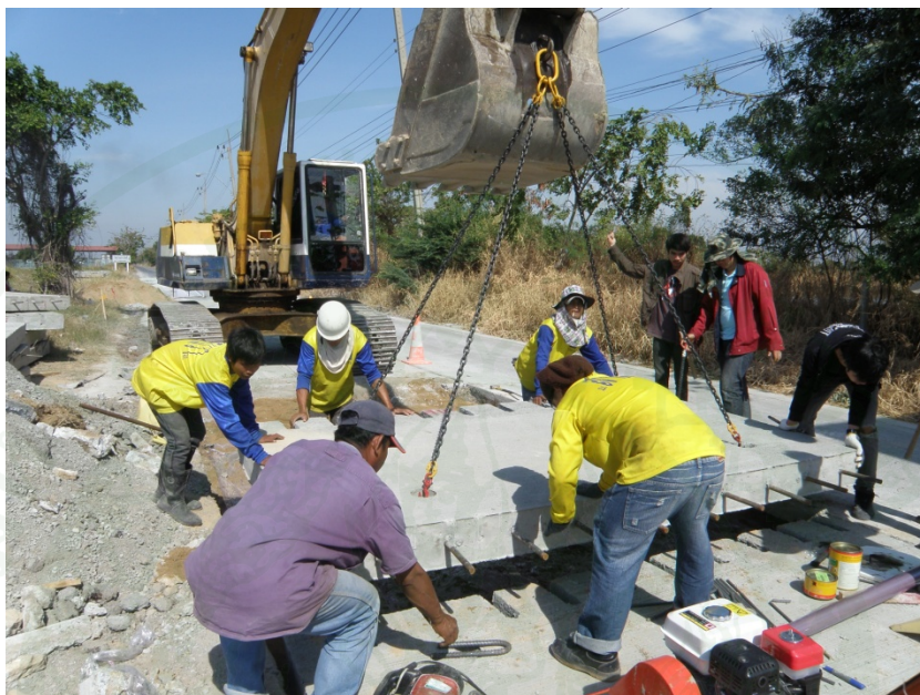
ภาพที่ 146 ติดตั้งแผ่นคอนกรีตสำเร็จรูป
