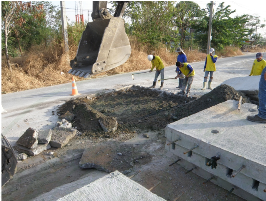
ภาพที่ 136 รื้อถนนเดิมออกด้วยรถ Back Hoe
