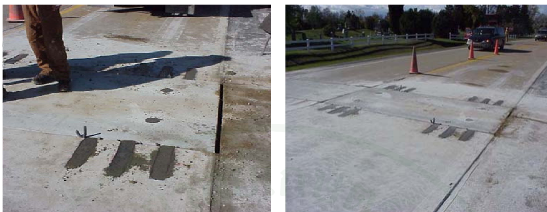
ภาพที่ 56 แผ่นคอนกรีตหล่อสำเร็จที่ติดตั้งเสร็จแล้ว (FHWA, 2007)
