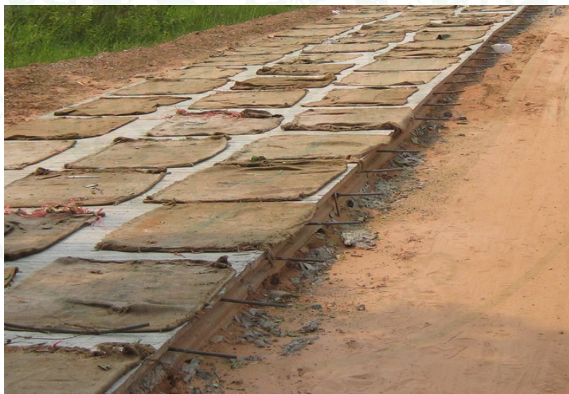
ภาพที่ 86 รอยต่อตามยาวและเหล็กข้ออ้อย Tie bar
