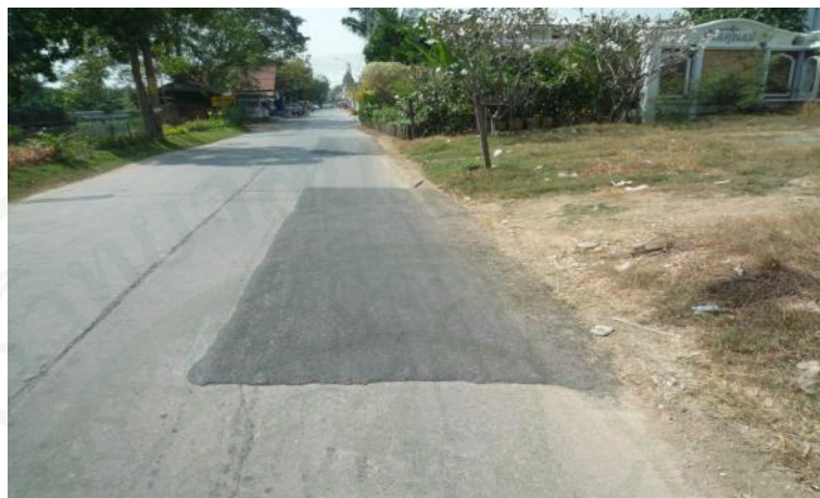
ภาพที่ 12 รอยปะซ่อมผิวคอนกรีตด้วยแอสฟัลต์คอนกรีต
