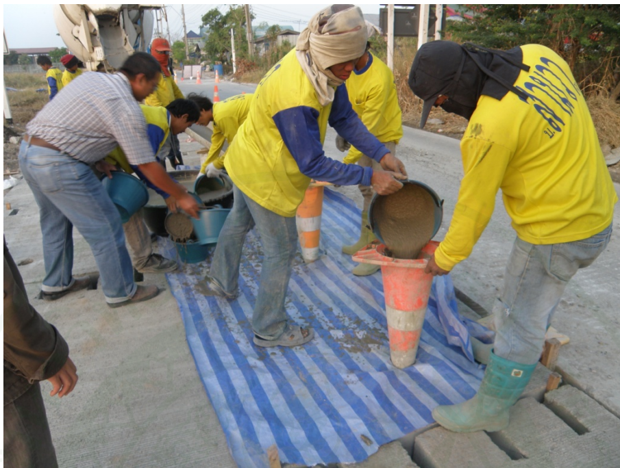
ภาพที่ 159 การเท Self Leveling Mortar
