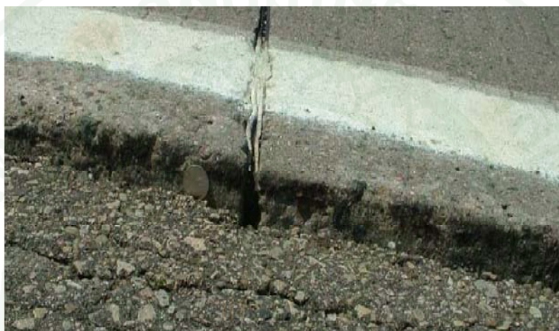
ภาพที่ 9 การทรุดตัวต่างระดับของไหล่ทาง (Stutevant, 2006)
