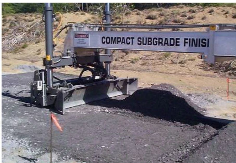
ภาพที่ 76 เครื่องมือปรับระดับพื้นที่ (Lacoss, 2008)
