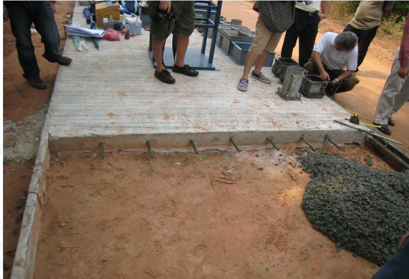
ภาพที่ 85 รอยต่อตามขวางและเหล็กกลม Dowel bar
