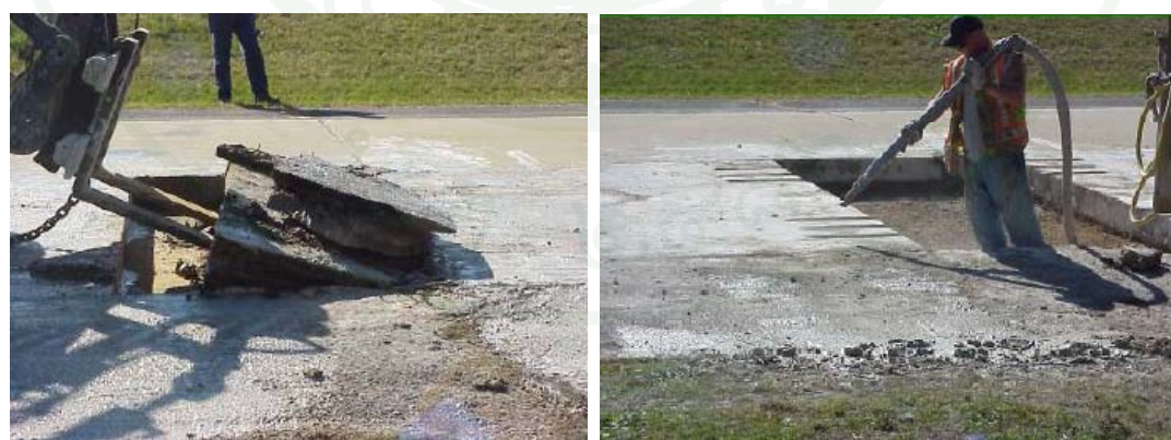
ภาพที่ 36 การรื้อถนนคอนกรีตที่เสียหายเพื่อใช้รองรับแผ่นคอนกรีตหล่อสำเร็จ (PCA, 2004)
