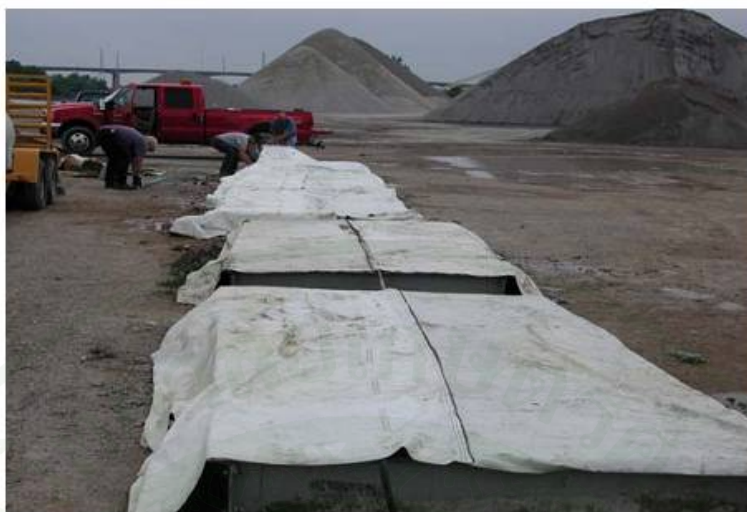
ภาพที่ 46 การบ่มแผ่นคอนกรีตสำเร็จรูป (FHWA, 2007)
