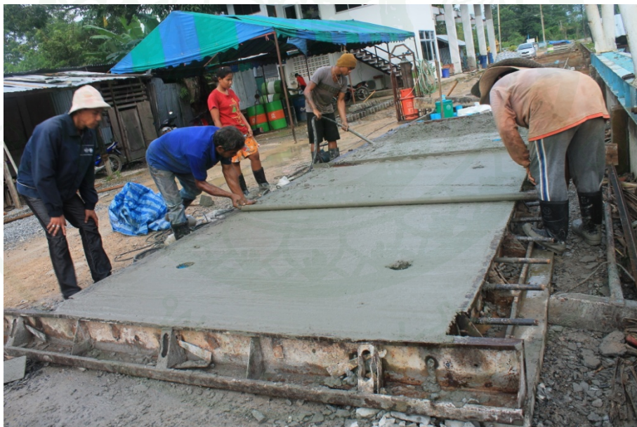
ภาพที่ 125 การปาดหน้าผิวคอนกรีต
