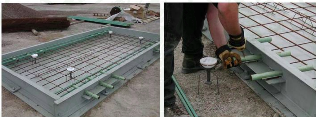
ภาพที่ 44 การเสริมเหล็กตะแกรงและเหล็กเดือ และจุดยกในแบบหล่อ (FHWA, 2007)
