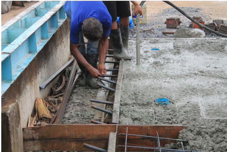
ภาพที่ 124 การจี้คอนกรีตและการจัดเหล็กเดือย
