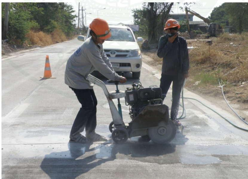
ภาพที่ 155 ตัดรอยต่อด้วยเครื่องตัดคอนกรีต
