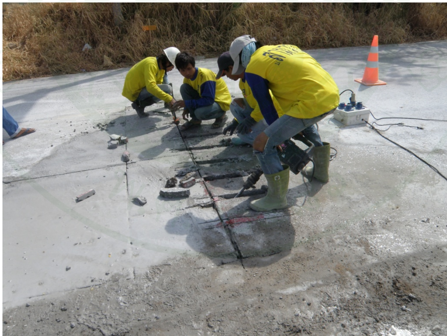
ภาพที่ 137 สกัดร่องเหล็กเค็ย
