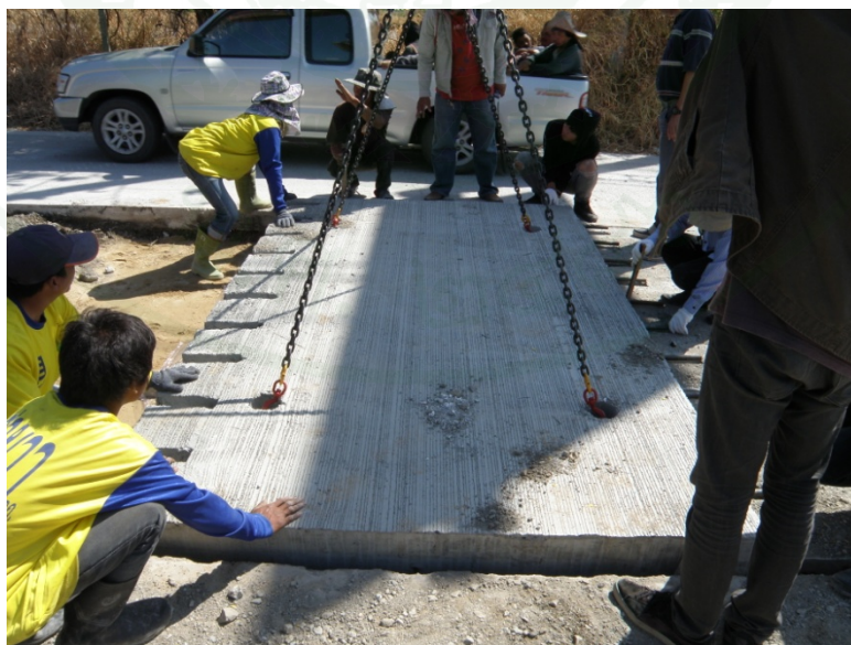
ภาพที่ 157 การติดตั้งแผ่นคอนกรีตสำเร็จรูปบนเข็มเหล็กค้ำรูปตัวยู
