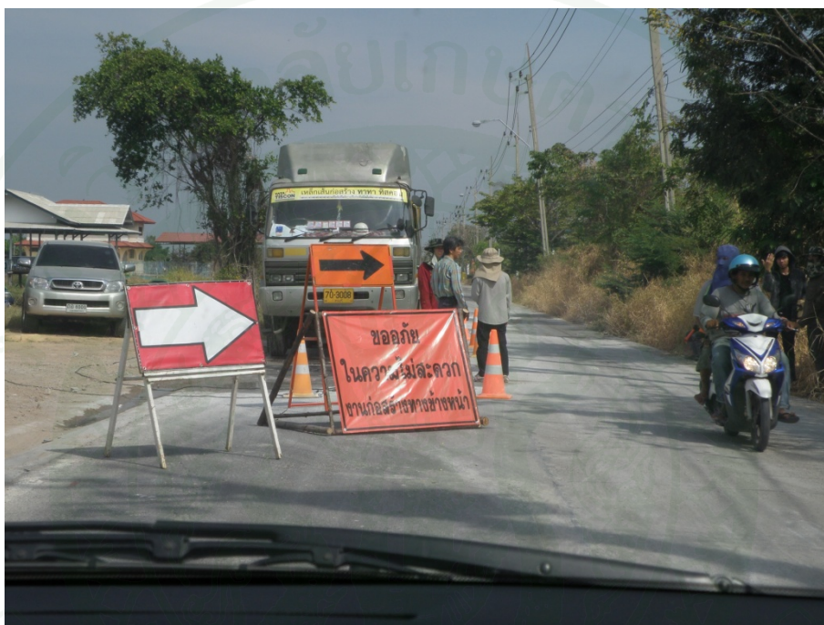
ภาพที่ 132 ติดตั้งป้ายเตือนและปิดการจราจร
