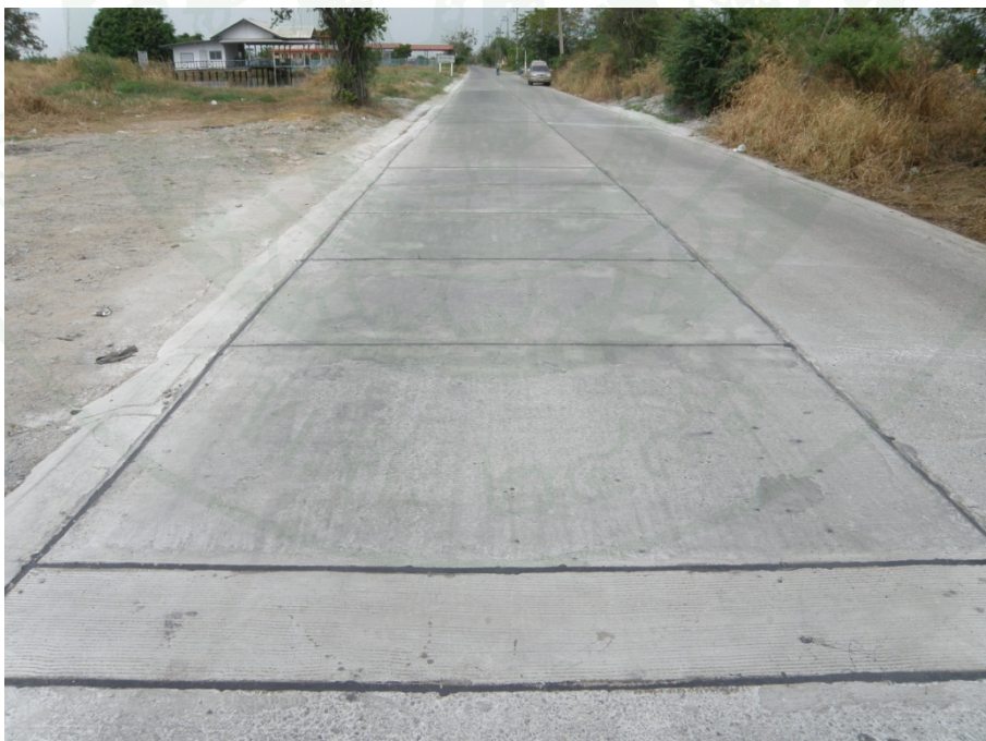
ภาพที่ 160 สภาพถนนภายหลังการซ่อมแซม
