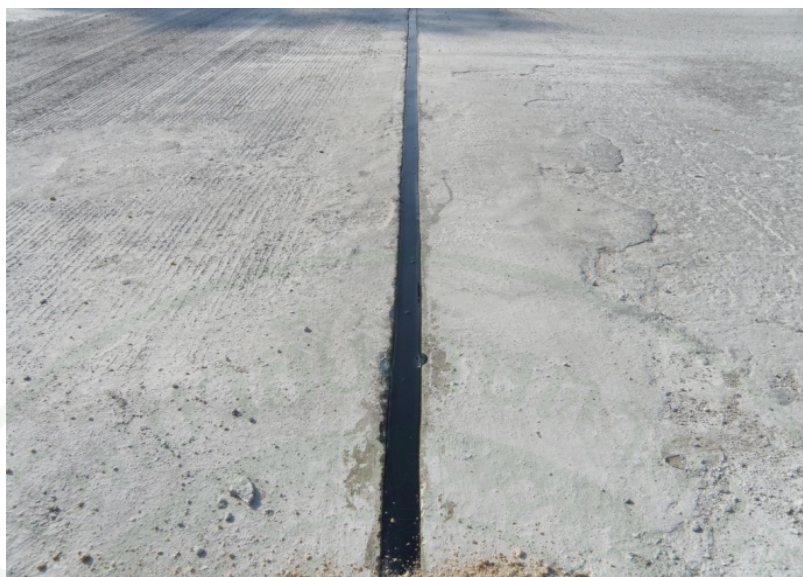
ภาพที่ 156 ปัดรอยต่อด้วย Joint Sealer
