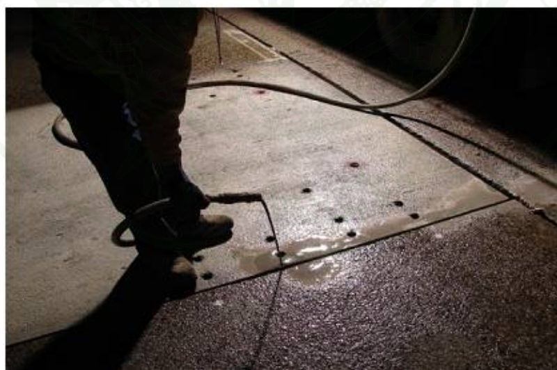
ภาพที่ 79 การอัดฉีดวัสดุเกรทเพื่อให้อุดรอยต่อ (Lacoss, 2008)
