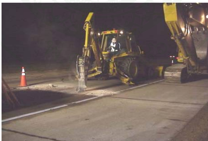
ก.) การใช้เครื่องมือ Jack Hammering ข่อยแผ่นคอนกรีต
