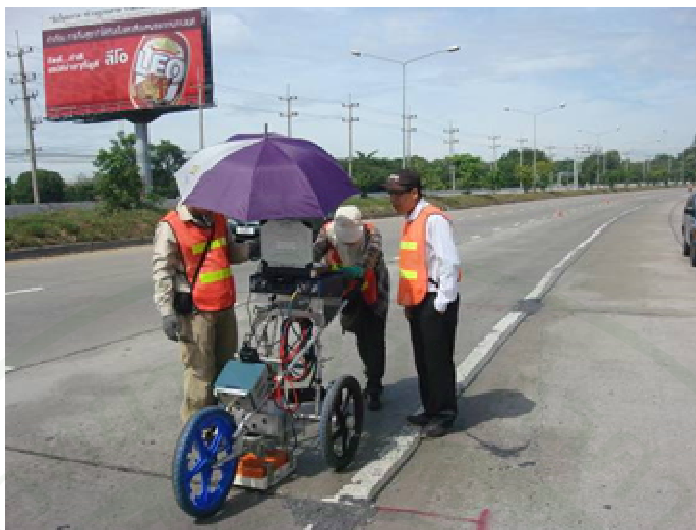
ภาพที่ 23 การสำรวจถนนคอนกรีตด้วยเครื่อง GPR (สำนักวิจัยและพัฒนาทาง กรมทางหลวง, 2552)
