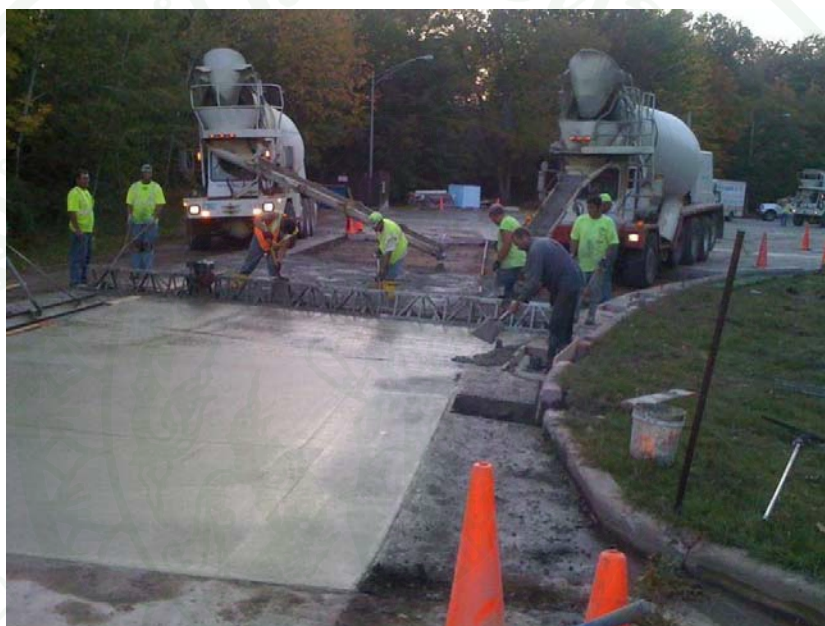
ภาพที่ 34 การซ่อมแซมแบบหล่อในที่ ( http://www.cprcontractors.com )
