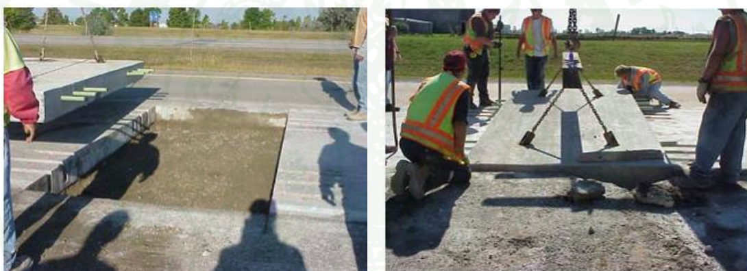
ก) การติดตั้งแผ่น Precast
