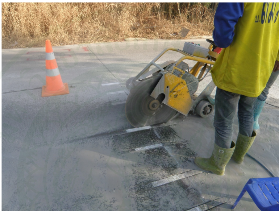
ภาพที่ 135 ตัดร่อง Dowel Bar Slot บนถนนเดิม
