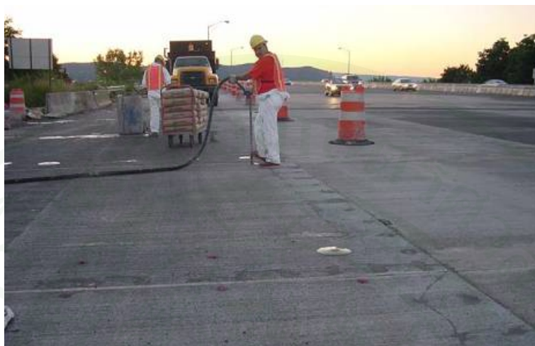
ภาพที่ 80 การอุดโพรงใต้แผ่นคอนกรีต (Lacoss, 2008)
