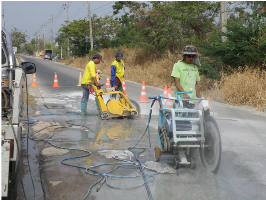
ภาพที่ 133 ตัดถนนคอนกรีตเดิมด้วยเครื่องตัดคอนกรีต
