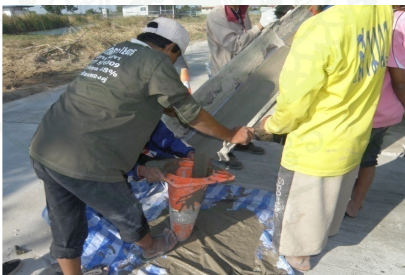
ภาพที่ 149 เท Self Leveling Mortar ด้วยรางส่งคอนกรีต
