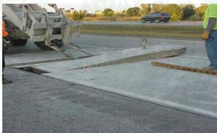
ข) การรื้อแผ่นคอนกรีต
