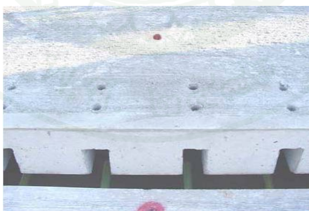
ภาพที่ 74 แสดงรูปแบบรอยต่อตามขวางของระบบ Super Slab (Tayabji, 2008)
