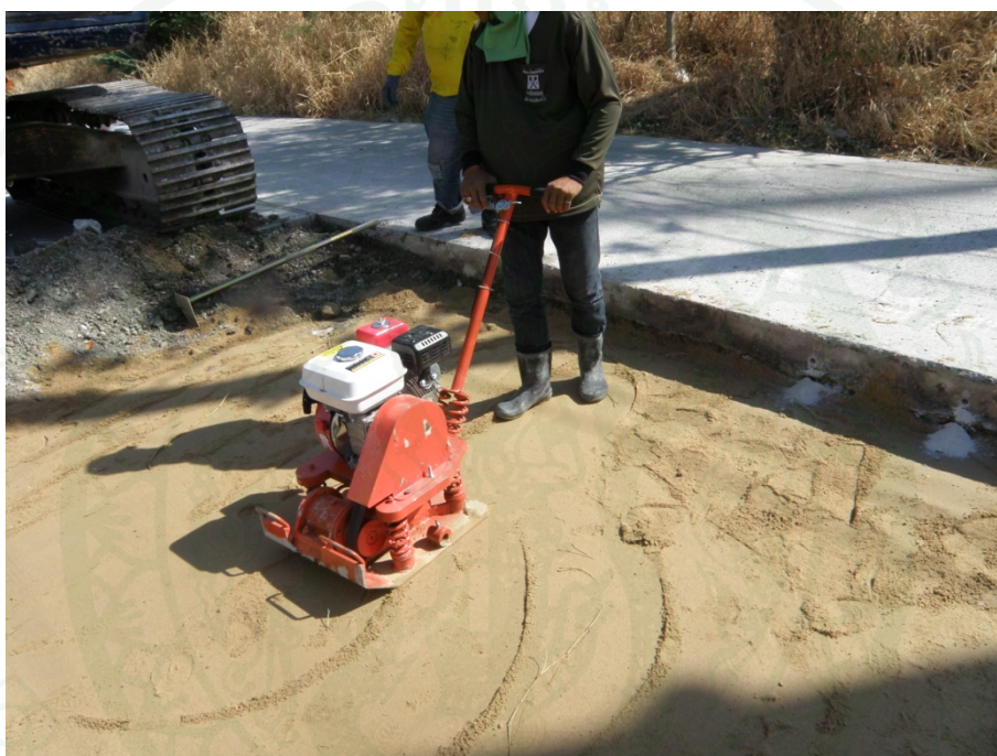
ภาพที่ 140 บดทรายหยาบด้วยเครื่องตบแบบกระโดด
