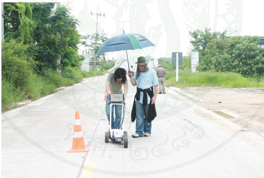
ภาพที่ 180 การตรวจวัด IRI แปลงทดสอบถนนคอนกรีตก่อนการซ่อมแซม
