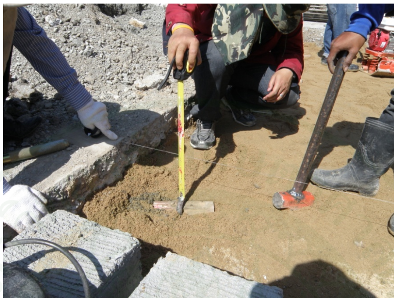
ภาพที่ 158 การวัดระดับของเข็มเหล็กตัดรูปตัวยู
