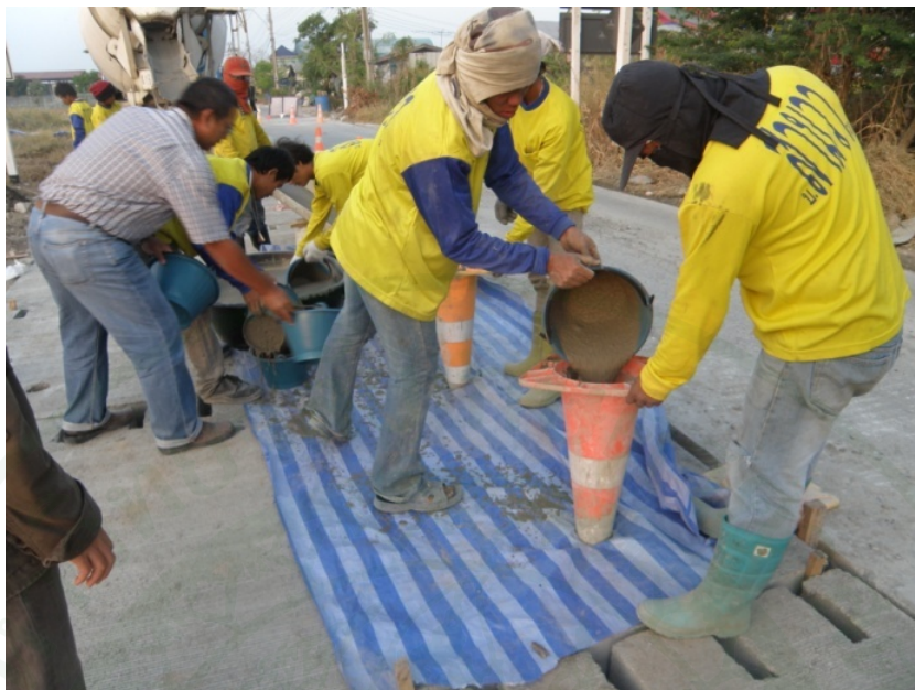
ภาพที่ 150 เท Self Leveling Mortar ด้วยการตักเท
