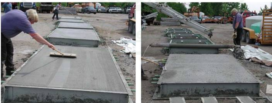
ภาพที่ 45 การหล่อแผ่นคอนกรีตหล่อสำเร็จและการแต่งหน้าแผ่นคอนกรีต (FHWA, 2007)
