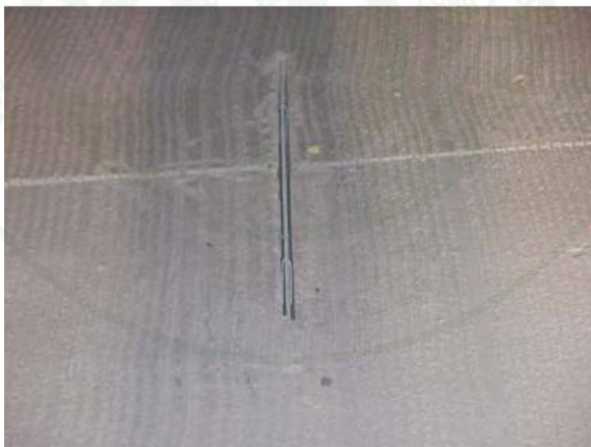
ภาพที่ 65 การติดตั้งตัวยึดแบบ Fiberglass (FHWA, 2007)
