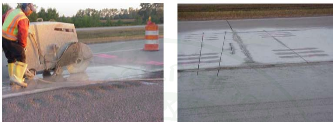
ก) การตัดแผ่นคอนกรีต
