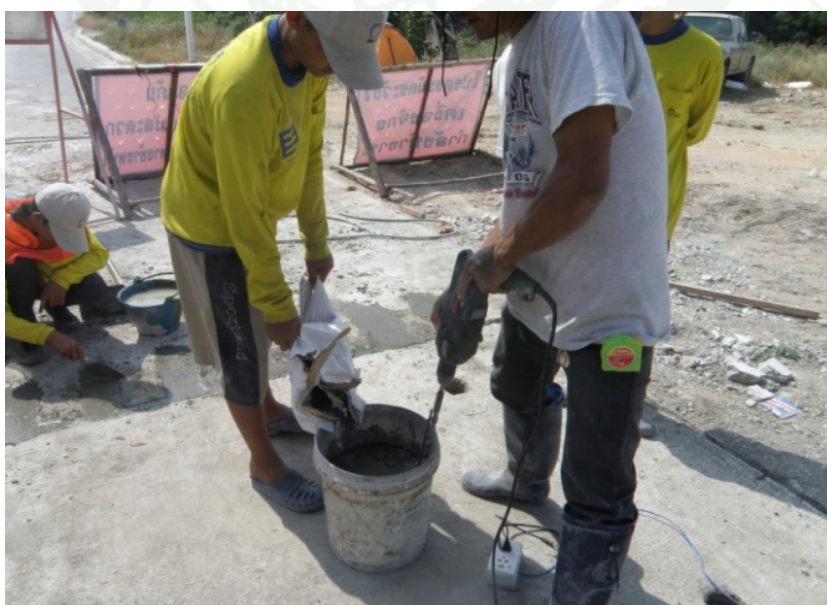
ภาพที่ 153 ผสม Non-Shrink Grout ด้วยการตีผสม
