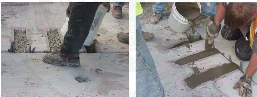
ภาพที่ 55 การเกรทช่อง Dowel Slots (FHWA, 2007)
