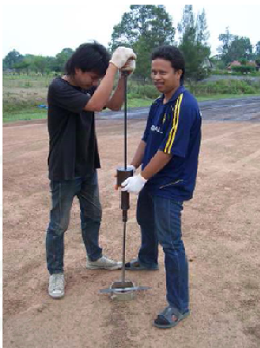
ภาพที่ 22 การทดสอบ Dynamic Cone Penetrometer (DCP) บนพื้นทางดินซีเมนต์ (เลิศและจุฑา, 2553)
