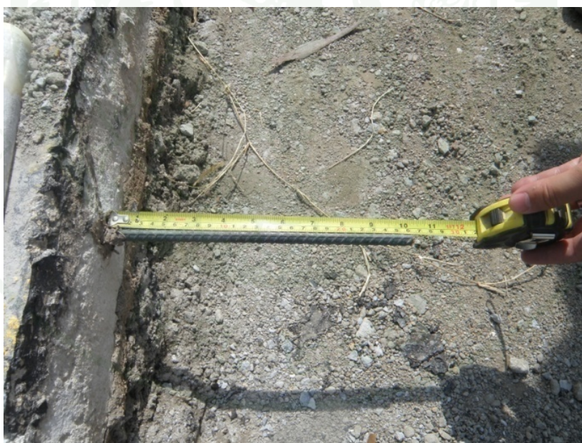
ภาพที่ 145 ติดตั้งเหล็กยึดให้ได้ระยะฝั่งเพียงพอ
