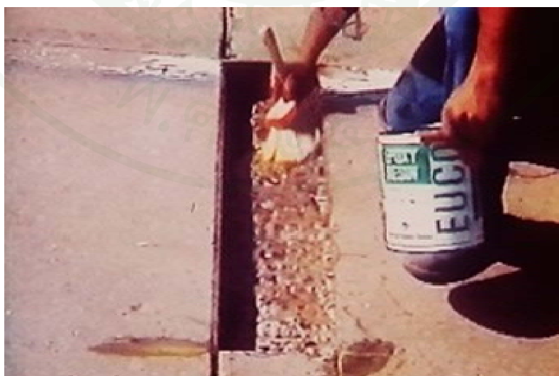
ภาพที่ 32 การซ่อมแซมบางส่วนของความหนา (มนัส, 2550)
