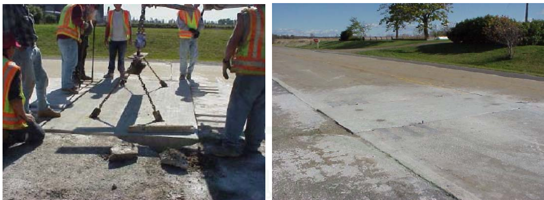
ภาพที่ 37 การติดตั้งแผ่นคอนกรีตหล่อสำเร็จ (PCA, 2004)
