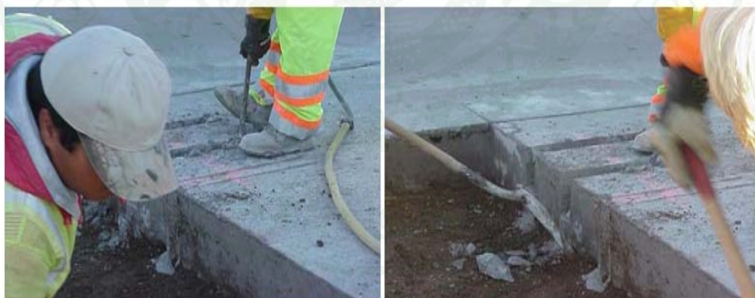
ก) การเจาะช่องสำหรับใช้เป็นรอยต่อถ่ายแรง
