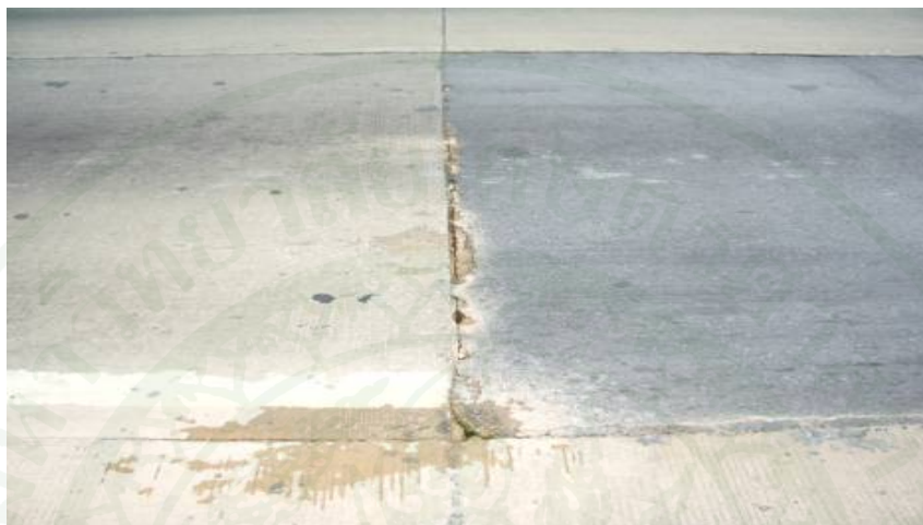
ภาพที่ 11 การสูญเสียมวลรวมละเอียดของชั้น โครงสร้างทาง (คู่มือการสำรวจหาโพรงฯ, 2552)
