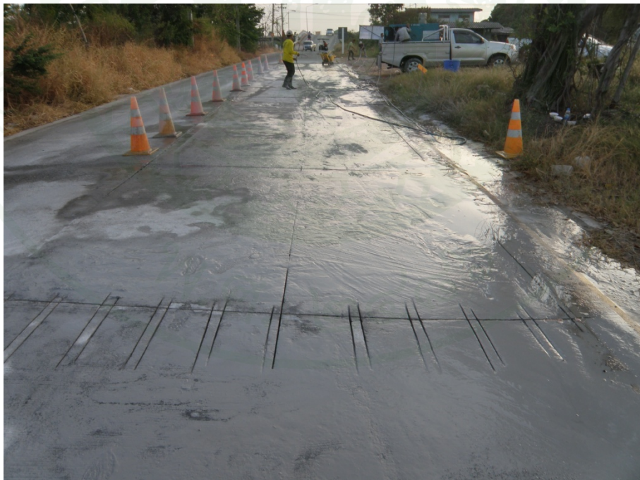
ภาพที่ 134 ภายหลังการตัดถนนเดิมจนรอบ
