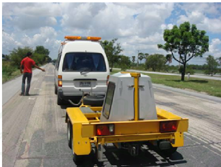
ภาพที่ 15 การทดสอบความแข็งแรงของโครงสร้างถนนด้วย Falling Weight Deflectometer (ฉันทวิน และอภิสิทธิ์, 2553)
