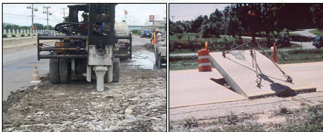
ภาพที่ 42 นำแผ่นพื้นคอนกรีตออกโดยวิธีทุบให้แตกหรือวิธียกออก
