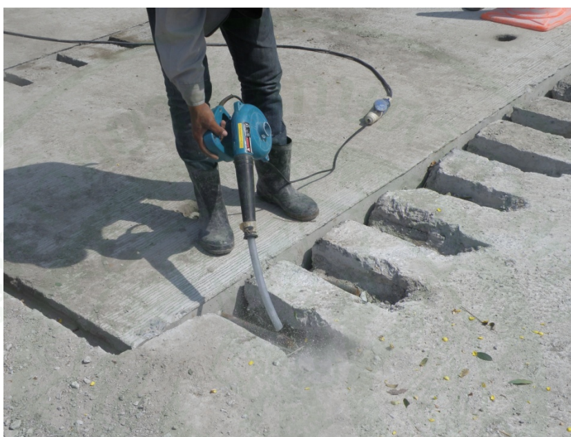
ภาพที่ 152 ทำความสะอาดรอยต่อด้วยเครื่องเป่าลม
