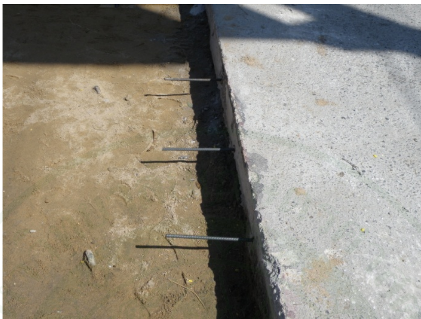
ภาพที่ 144 เสียบเหล็กยึดตามระยะที่กำหนด
