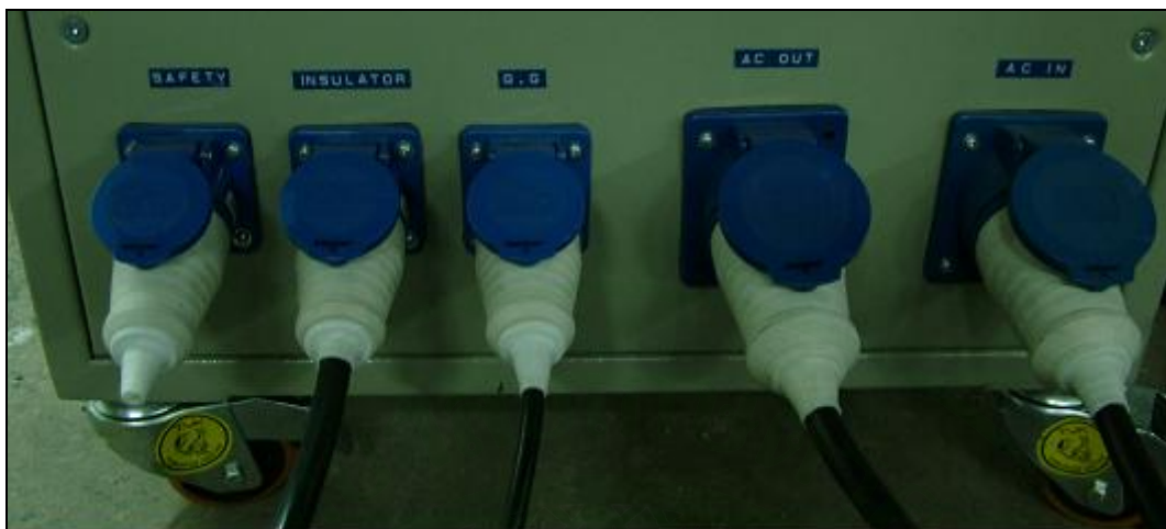
ภาพผนวกที่ ๓๘ การต่อปลั๊กเพาเวอร์ที่ตู้ชุดควบคุม
