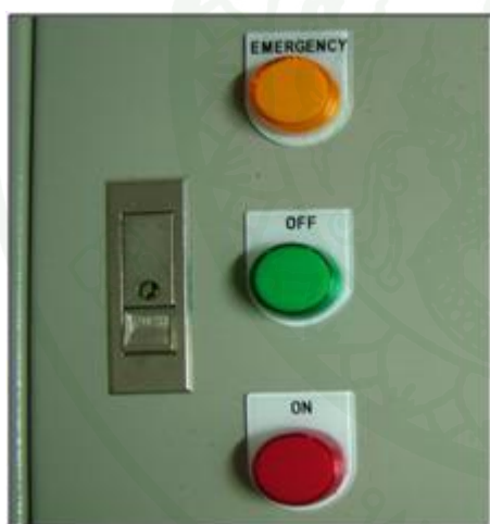
ภาพผนวกที่ ๑๑๔ ตำแหน่งหลอดสัญญาณไฟต่างๆ บนชุดควบคุม
