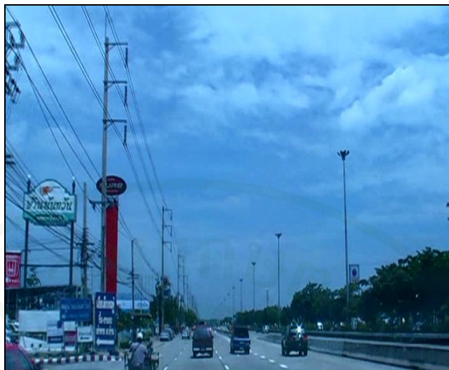
ภาพที่ 2 สายส่งจ่ายแรงดัน 115 เควี. บริเวณถนนกาญจนาภิเษก ของการไฟฟ้านครหลวง
