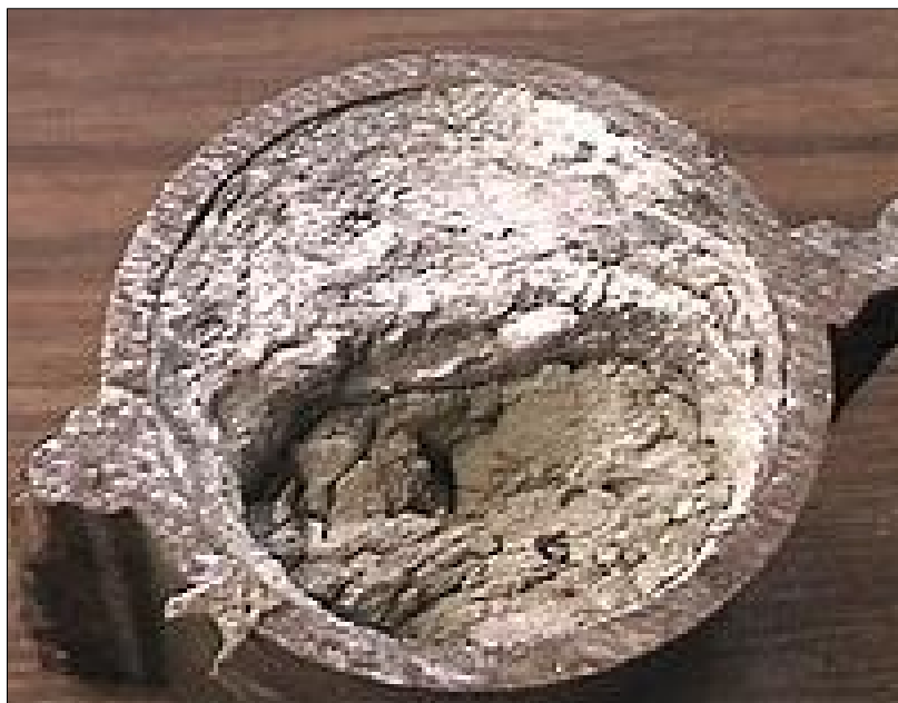
ภาพที่ 1 สภาพท่อน้ำของหม้อไอน้ำที่อุดตัน เนื่องจากระบบการโบสตัววนตะกอนหม้อไอน้ำไม่ดี
