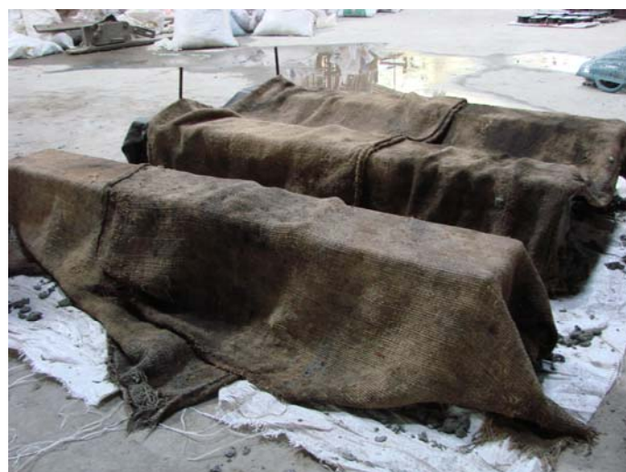
ภาพที่ 31 กระสอบเปียกน้ำคลุมตัวอย่างคานคอนกรีตควบคุม เพื่อป้องกันการระเหยของน้ำ
