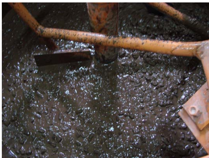
ภาพที่ 13 การผสมจีโอโพลิเมอร์คอนกรีต
