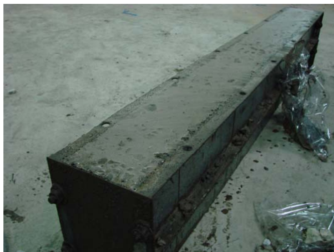
ภาพที่ 29 ตัวอย่างคานจีโอโพลีเมอร์คอนกรีต
