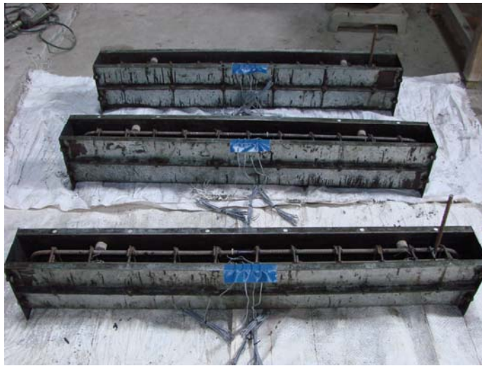
ภาพที่ 28 แบบหล่อและเหล็กเสริม
