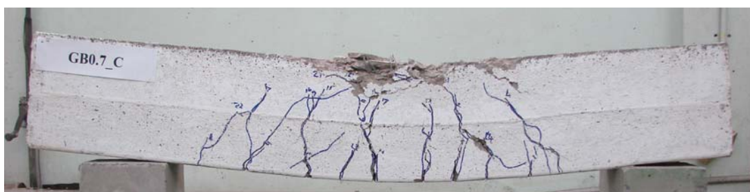
ภาพที่ 55 การวิบัติของคานจีโอโพลิเมอร์คอนกรีต 0.7-C
