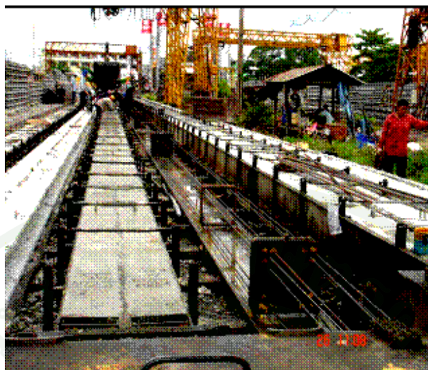
ภาพที่ 13 หลังจากตึงสายอัดแรงแล้ว
