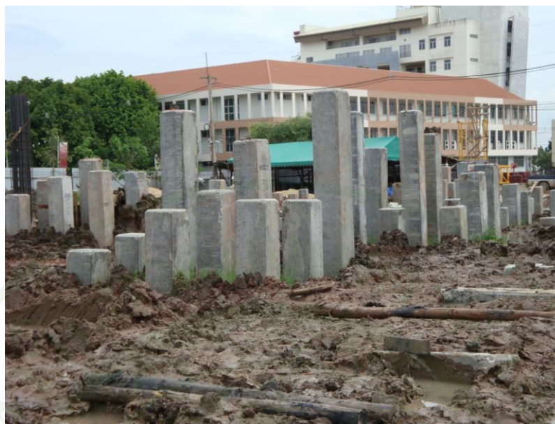
ภาพที่ 10 แสดงเสาเข็มที่ทำการตอกเสร็จแล้ว
