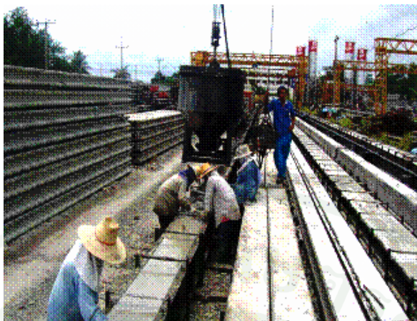
ภาพที่ 15 แสดงการเทคอนกรีตหล่อเสาเข็ม Batter Pile SQ 0.45 x 0.45 x 10.00 เมตร
