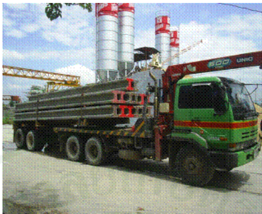
ภาพที่ 17 แสดงการขนส่งเสาเข็มเข้าไปในสถานที่ก่อสร้าง
