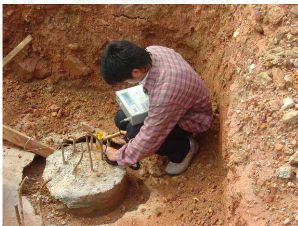
ภาพที่ 29 การใช้ค้อนเคาะลงบนหัวเสาเข็มทดสอบ
