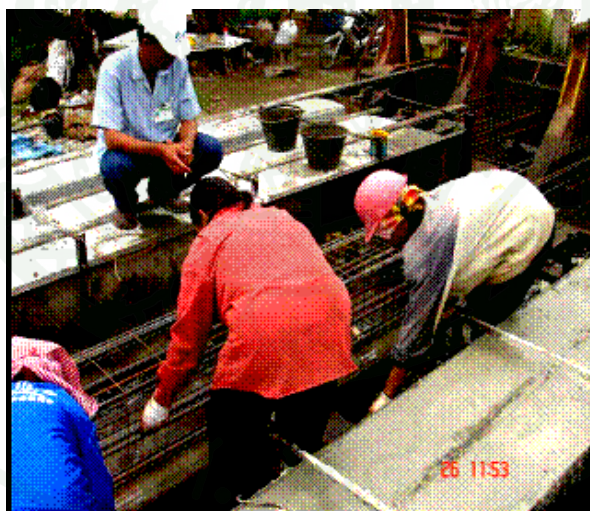
ภาพที่ 14 แสดงการผูกเหล็กปลอกเสาเข็ม
