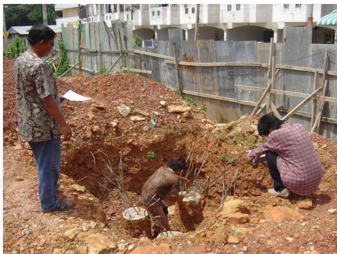
ภาพที่ 27 การเตรียมให้ไม่มีสิ่งกีดขวางบนหัวเสาเข็ม
