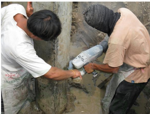
ภาพที่ 40 แสดงการวัดระยะหัวเสาเข็มโดยใช้เครื่องตัดไฟฟ้า
