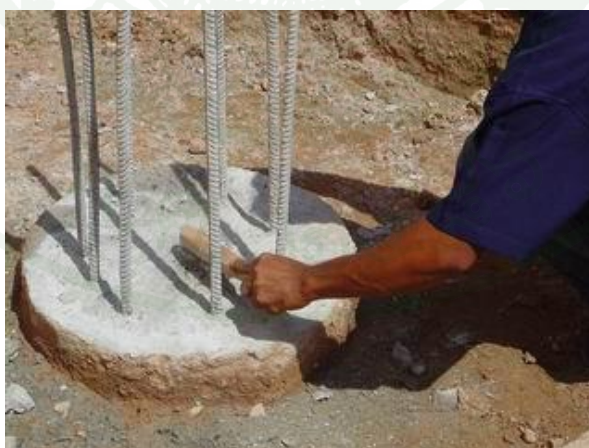
ภาพที่ 26 การเตรียมหัวเสาเข็มทดสอบ
