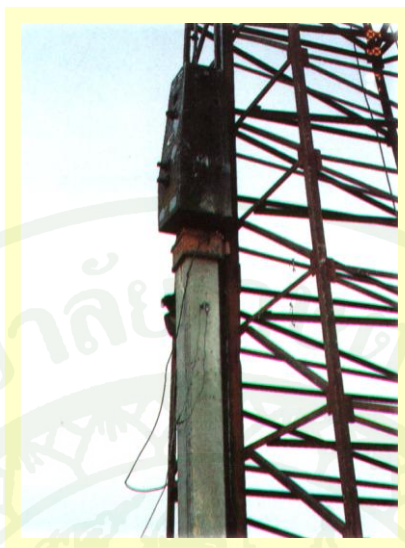
ภาพที่ 49 ปล่อดัมน้ำหนักลงมากระแทกที่หัวเสาเข็มและทำการยกและปล่อยตกตามระยะต่าง ๆ ที่ ได้กำหนดไว้
