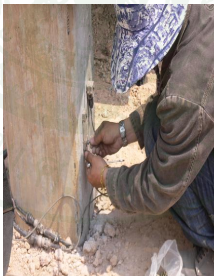
ภาพที่ 46 การติดตั้ง Strain Gauges และ Accelerometer
