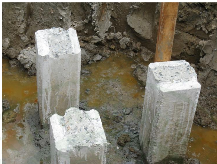
ภาพที่ 41 เสาเข็มที่ทำการสกัดผิวแล้ว
