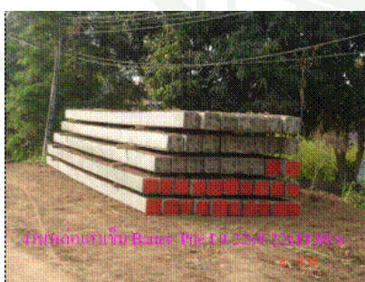
ภาพที่ 18 งานกองเสาเข็มสี่เหลี่ยมตัน Batter Pile
