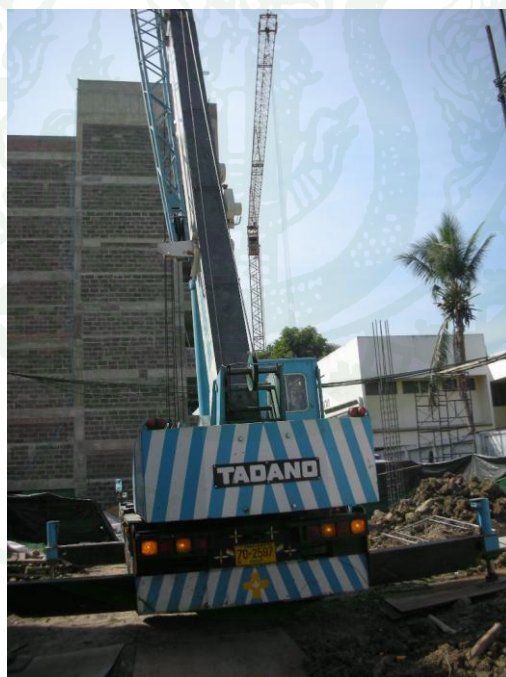
ภาพที่ 38 รถเครนที่ใช้ในการตอกเสาเข็ม
