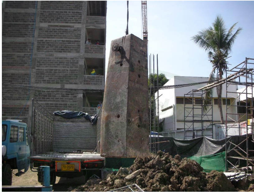
ภาพที่ 39 ดัมน้ำหนักที่ใช้ในการตอกเสาเข็ม
