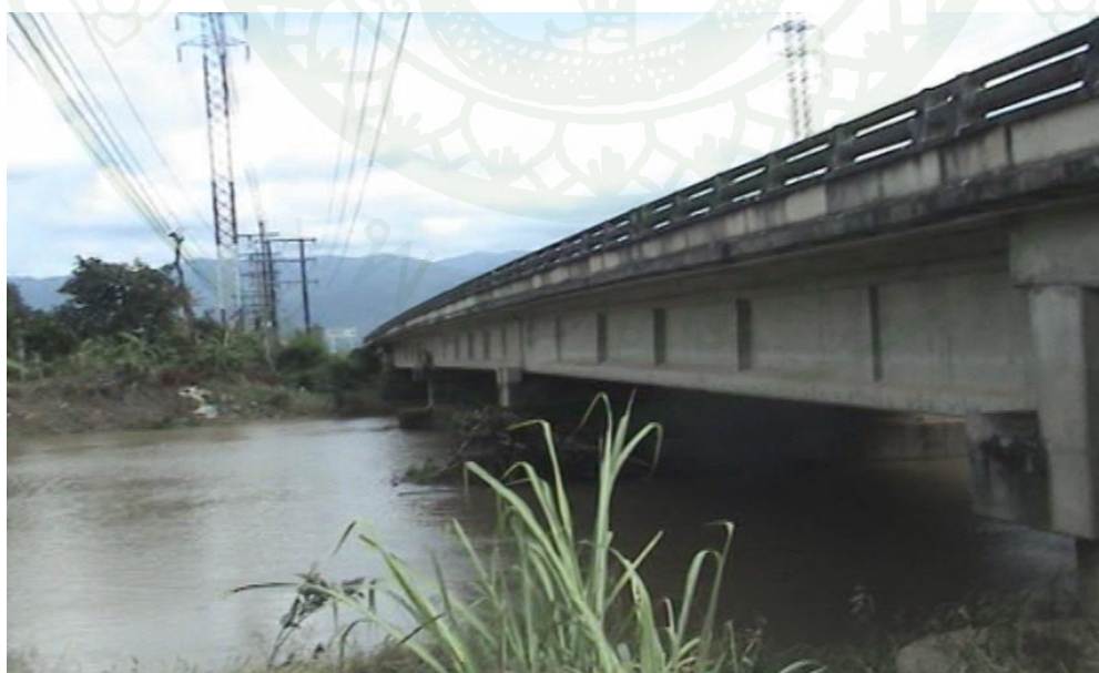
ภาพที่ 17 ภาพสะพานข้ามแม่น้ำจันทบุรี จังหวัดจันทบุรี
