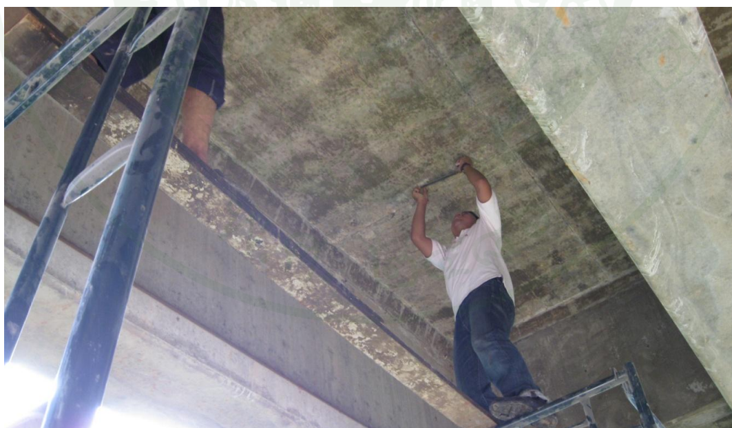
ภาพผนวกที่ ๑11 การกำหนดตำแหน่งติดตั้งเกจวัดความเครียดใต้สะพานข้ามแม่น้ำแคว จังหวัด ตราด
