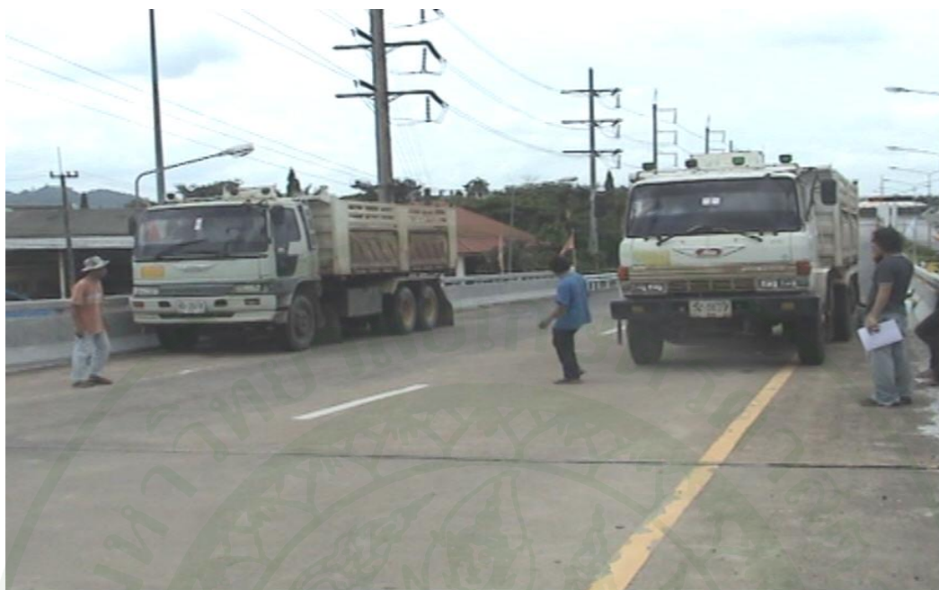
ภาพผนวกที่ 18 การปิดการจราจร นำรถเข้าตำแหน่งที่ทำให้เกิดค่าโมเมนต์ดัดบวกสูงสุดใน พื้นสะพาน และดับเครื่องยนต์เพื่อให้นิ่งสนิท
