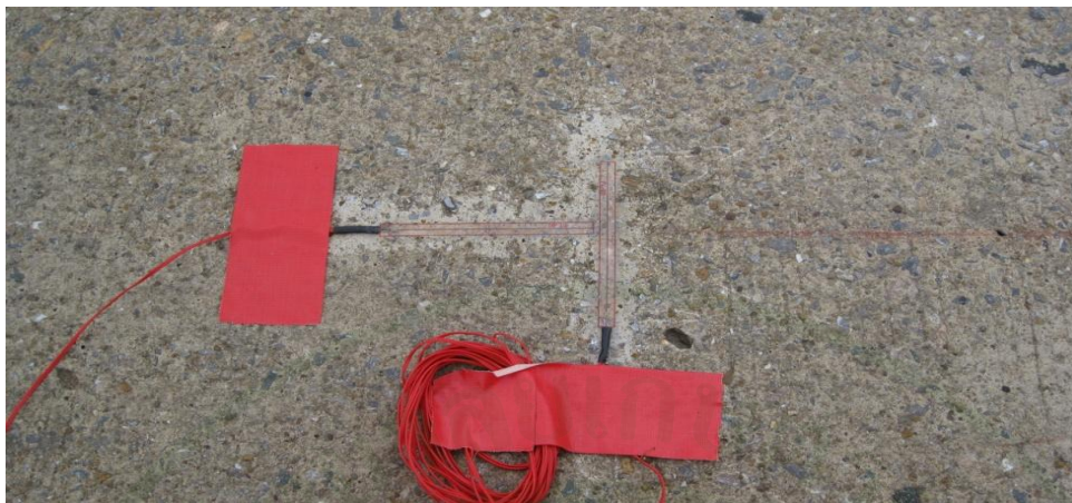
ภาพที่ 26 การติดตั้งมาตรวัดความเครียดสำหรับบนพื้นสะพานเพื่อนำไปคำนวณหาค่า โมเมนต์ดัดกลับสูงสุดในพื้นสะพาน
