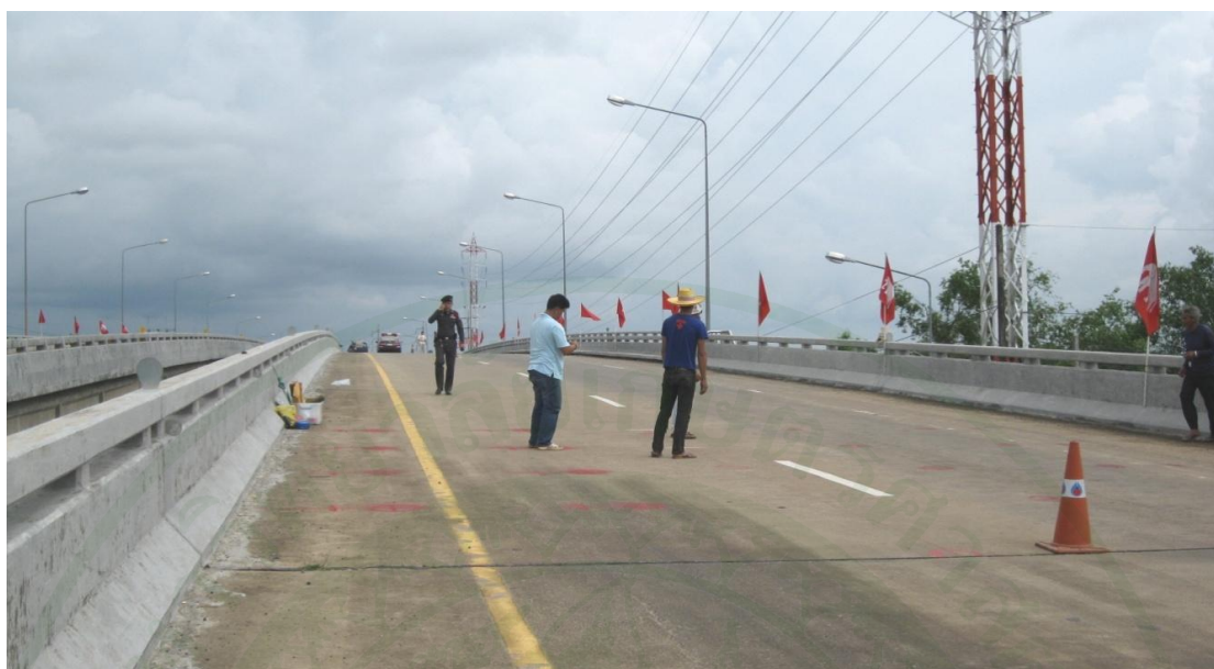
ภาพผนวกที่ ๒๐ ตำรวจทางหลวงจังหวัดตราด ช่วยอำนวยความสะดวกในการปิดการจราจรเพื่อ ทำการทดสอบสะพาน
