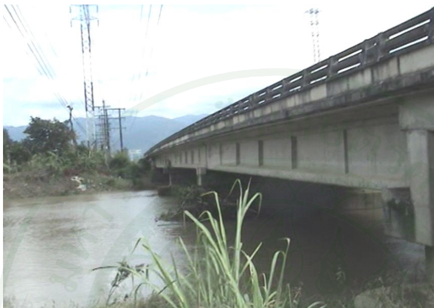
ภาพผนวกที่ ๔4 แสดงสะพานข้ามแม่น้ำจันทบุรี จังหวัดจันทบุรี ความยาวช่วงสะพาน 30 เมตร
