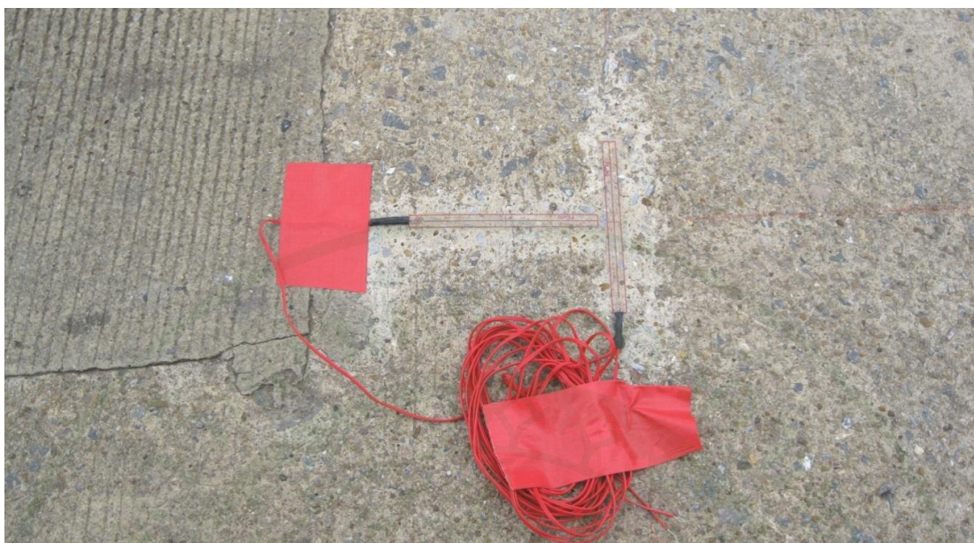
ภาพผนวกที่ 16 การติดตั้งเกจวัดความเครียดบนพื้นสะพานในทิศทางขนานกับการจราจร และในทิศทางขวางกับการจราจร
