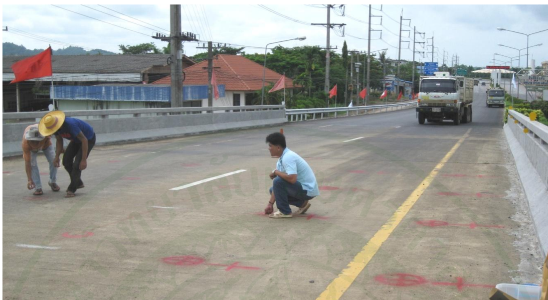
ภาพผนวกที่ 14 การกำหนดตำแหน่งล้อรถ และตำแหน่งการติดตั้งมาตรวัดความเร็วที่ ด้านบนพื้นสะพานข้ามแม่น้ำเวฬุ จังหวัดตราด
