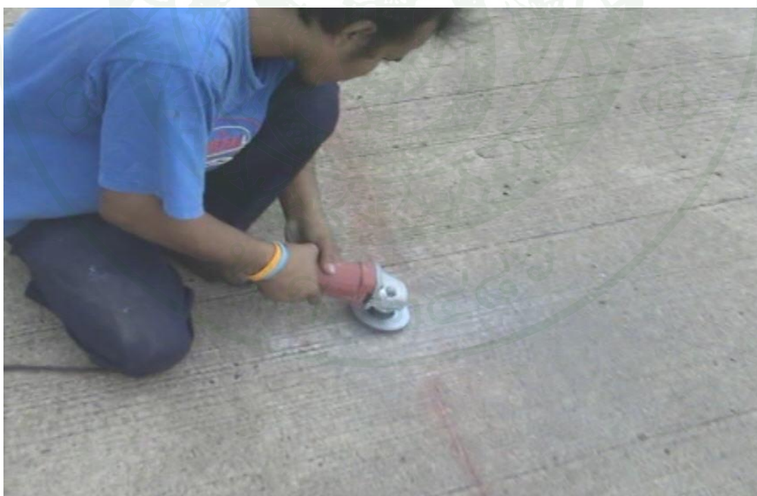
ภาพผนวกที่ 15 การเจียรพื้นผิวคอนกรีตบนพื้นสะพานบริเวณที่จะทำการติดตั้งเกจวัด ความเร็วให้เรียบ
