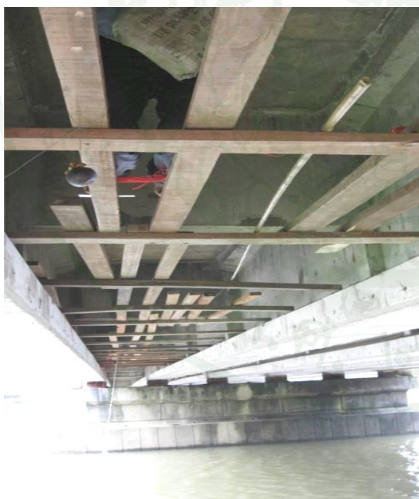
ภาพผนวกที่ ๗ การติดตั้งทางเดินใต้สะพานจนถึงกึ่งกลางสะพาน สำหรับการติดตั้งเกจวัดความเครียด
