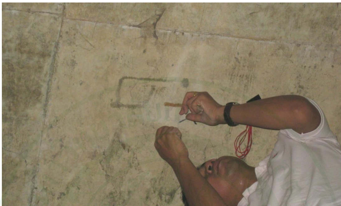
ภาพผนวกที่ 12 การติดตั้งเกจวัดความเครียดใต้สะพานข้ามแม่น้ำแควฯ จังหวัดตราด
