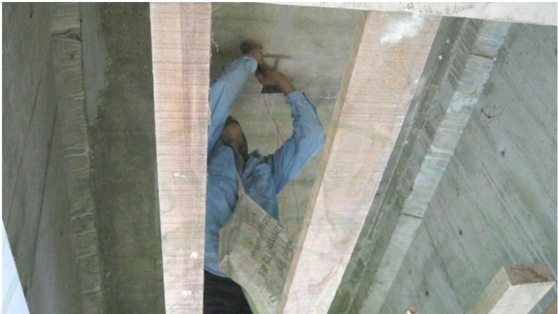
ภาพผนวกที่ ๘ การติดตั้งเกจวัดความเครียดใต้สะพานข้ามแม่น้ำจันทบุรี
