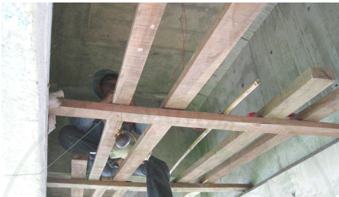
ภาพผนวกที่ ๖ การวางไม้พาดทำเป็นทางเดินเพื่อติดตั้งเกจวัดความเครียด (strain gauge)
