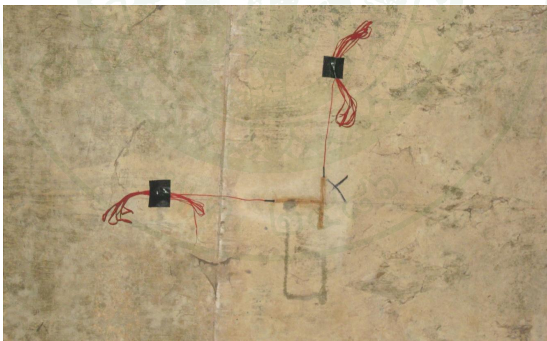
ภาพผนวกที่ 13 เกจวัดความเครียดใต้พื้นสะพานที่ติดตั้งเรียบร้อยแล้ว ในทิศทางขนานกับการจราจร และในทิศขวางกับการจราจร
