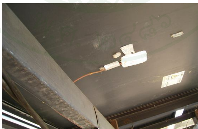
ภาพที่ 20 ตำแหน่งการติดตั้งสายเทอร์โมคัปเปิลบริเวณด้านหลังแผงเซลล์แสงอาทิตย์
