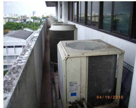
(ข) การติดตั้งคอยล์ร้อนในพื้นที่ที่แคบ
