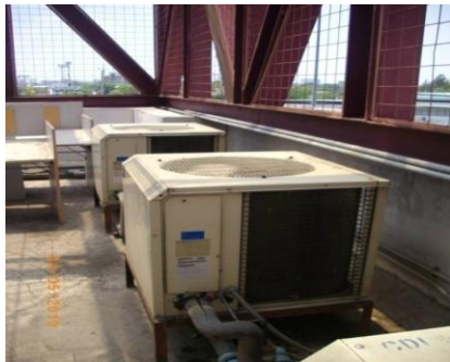
(ก) การติดตั้งคอยล์ร้อนที่มีแดดส่องถึง ภาพที่ 4.8 ลักษณะการติดตั้งคอยล์ร้อน
