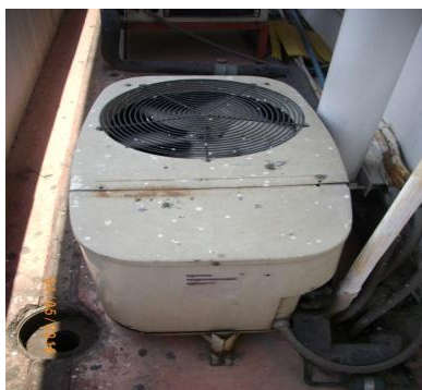
(ก) การติดตั้งที่อาคาร 5
