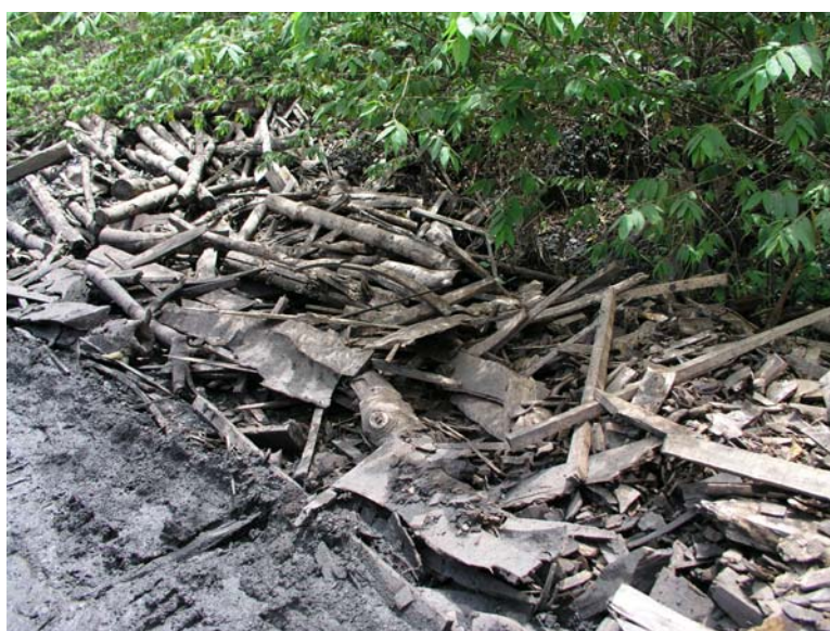
ภาพที่ 20 ไม้ที่กระจัดกระจายออกนอกกองก็ดขวางเส้นทางระบายน้ำ
