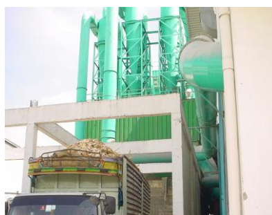
ภาพที่ 2.26 การป้องกันฝุ่นของไม้โดยการติดตั้งเครื่องดูดฝุ่นเข้าสู่ ไซโล ด้านหลังโรงงาน
