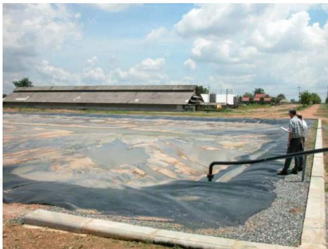
ภาพที่ 2 การบำบัดน้ำเสียจากฟาร์มสุกรด้วยระบบบำบัดน้ำเสียแบบบ่อดินปิดคลุมด้วยพลาสติก ที่มา: ศูนย์ประสานงานโครงการส่งเสริมเทคโนโลยีชีวภาพ (2551)
