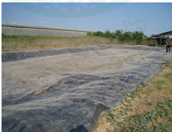
ภาพที่ 6 ระบบบำบัดน้ำเสียแบบบ่อดินปิดคลุมด้วยพลาสติกในฟาร์มสุกรตัวอย่าง ที่มา: จากการสำรวจ
