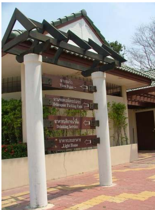
ภาพที่ 4.35 ป้ายบอกทางที่ปรับปรุงใหม่ แต่ไม่ได้รับการดูแลรักษา
