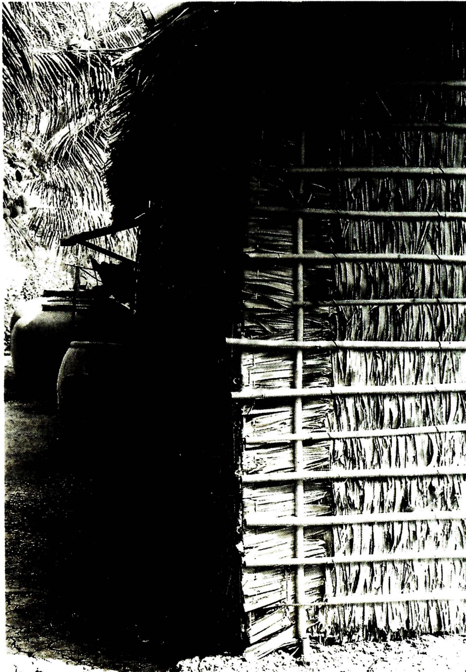
รายละเอียดของผนังกรูจาก สังกะศบริเวณมุมเรือนจะวางค้ำในแนวตั้งต่างกับส่วนของผนัง
