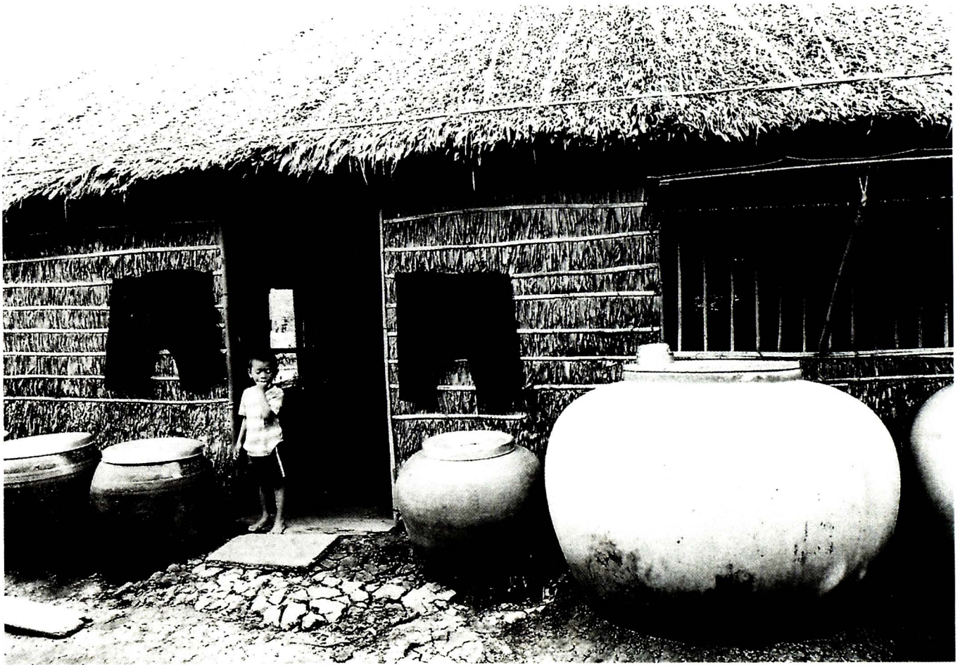
ตุ่มน้ำเพื่อรองน้ำฝนจากชายคาสำหรับใช้ดื่มกินวางชิดกับผนัง ในภาพจะเห็นการเจาะช่องหน้าต่างเป็นหน้าต่างบานกระทุ้งมีลูกกรงเป็นไม้ไผ่ลำเล็ก ช่องหน้าต่างจะเจาะตรงผนังด้านใต้เพื่อรับกระแสลมที่พัดอยู่เป็นประจำ
