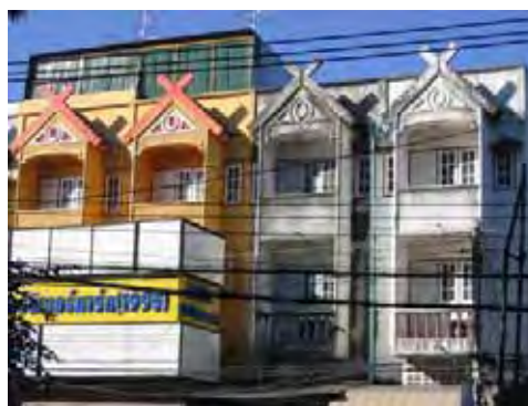
ภาพที่ 19 อาคารพาณิชย์ในจังหวัดเชียงใหม่
