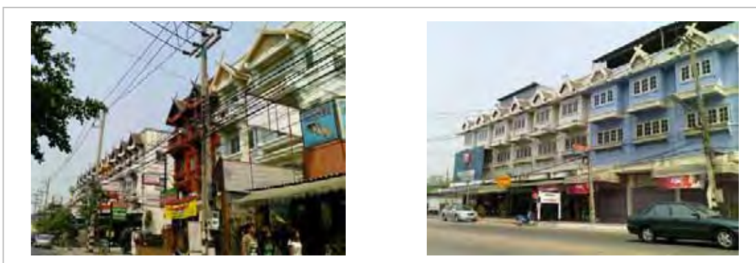
ภาพที่ 76 อาคารพาณิชย์ในจังหวัดเชียงใหม่
