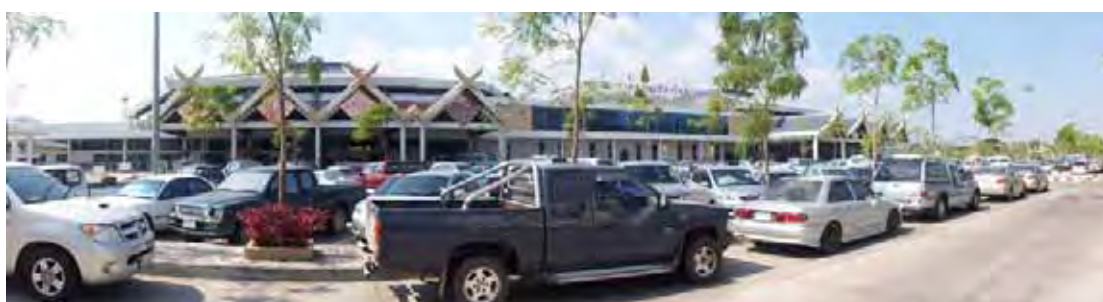
ภาพที่ 38 อาคารท่าอากาศยานภายในประเทศ (เก่า) และระหว่างประเทศ (ใหม่) สนามบินเชียงใหม่
