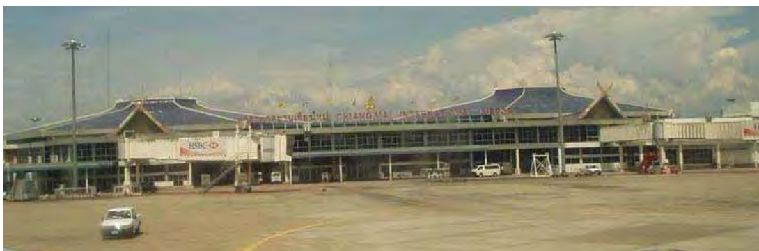
ภาพที่ 37 ด้านหลังของอาคารท่าอากาศยานเชียงใหม่ (มุมมองจาก run way)
