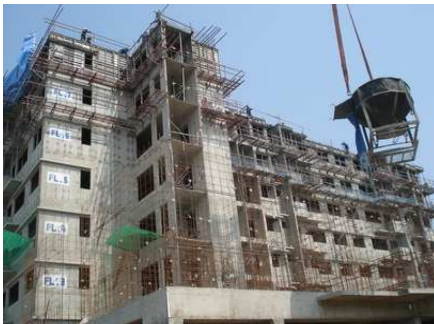
ภาพที่ 11 งานก่อสร้างช่องลิฟต์
