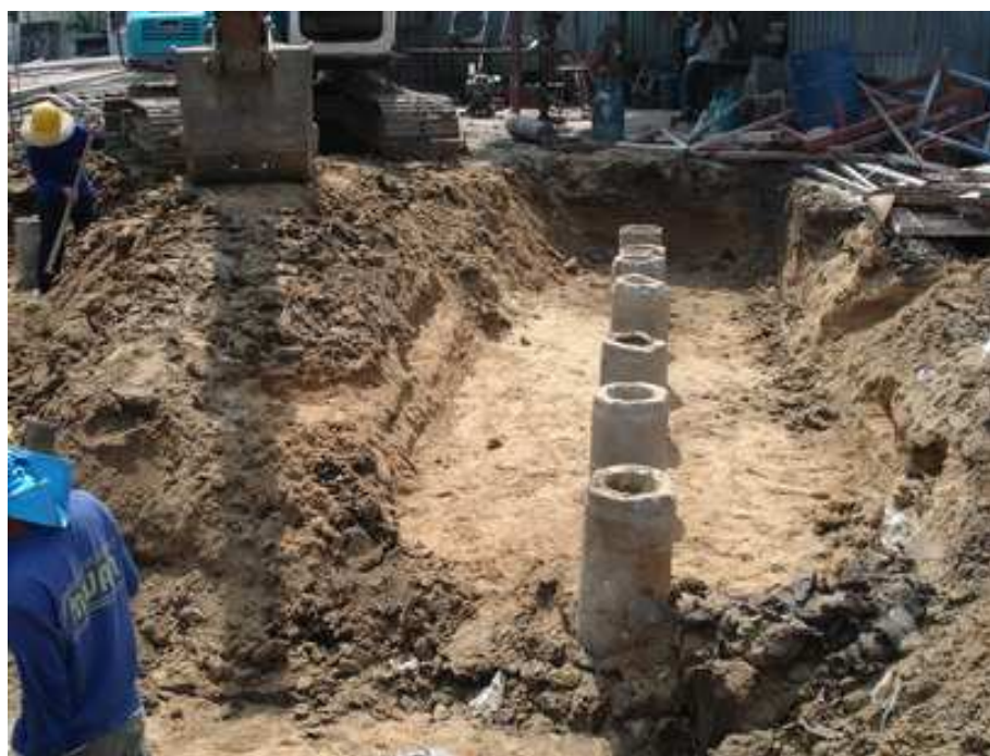
ภาพที่ 8 งานเสาเข็มภายในโครงการ
