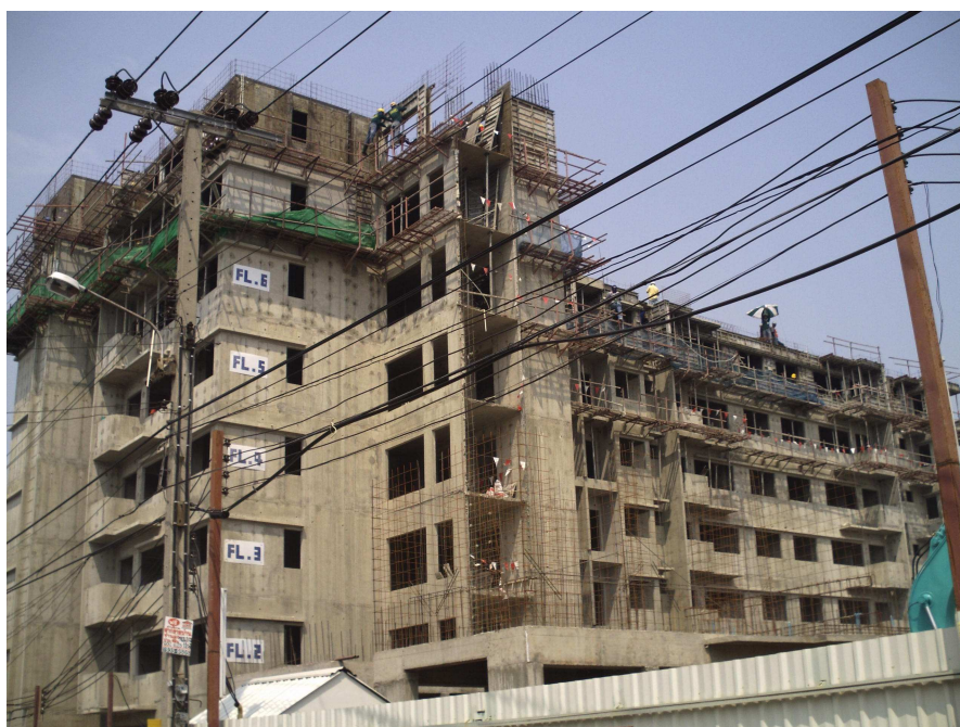
ภาพที่ 14 งานก่อสร้างงานโครงสร้างจากตำแหน่งชั้นที่ 2 ถึง ชั้นที่ 6
