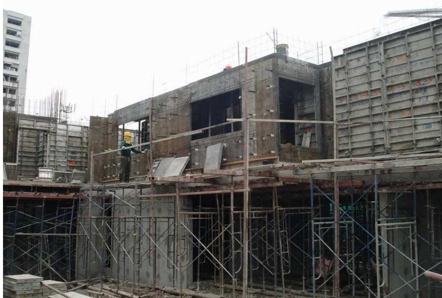
ภาพที่ 13 งานหล่อผนังคอนกรีตเสริมเหล็กแบบไมวาน(MIVAN)
