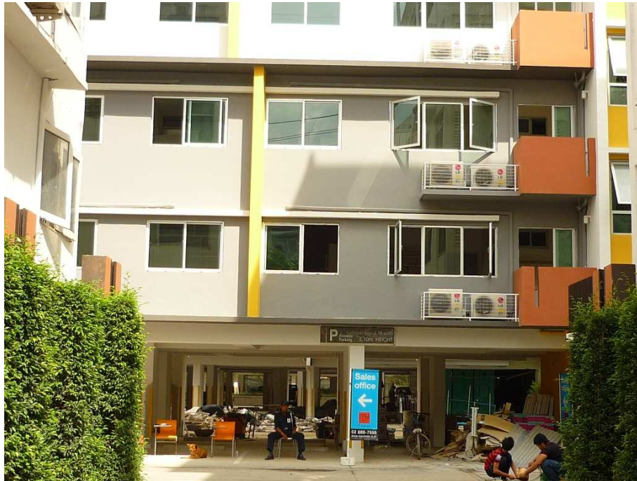
ภาพที่ 1 ทางเข้าโครงการจากถนนใหญ่
