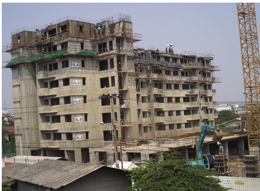
ภาพที่ 16 งานก่อสร้างงานโครงสร้างบริเวณโดยรอบโครงการ
