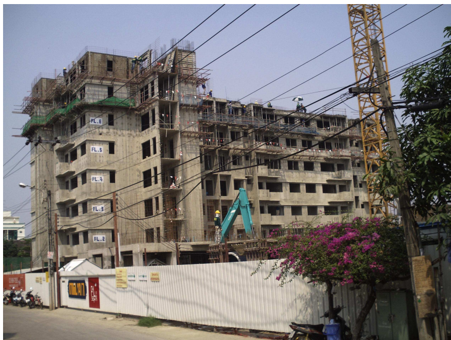
ภาพที่ 15 งานก่อสร้างงานโครงสร้างบริเวณด้านข้างของโครงการ
