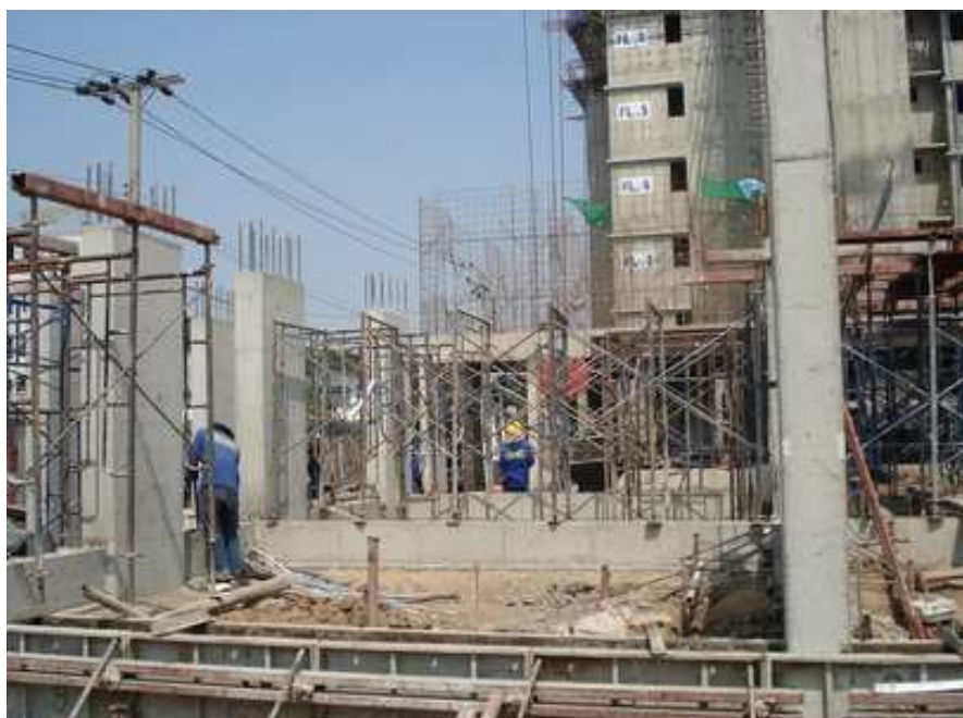
ภาพที่ 12 การก่อสร้างงานโครงสร้างตามจุดต่าง ๆ
