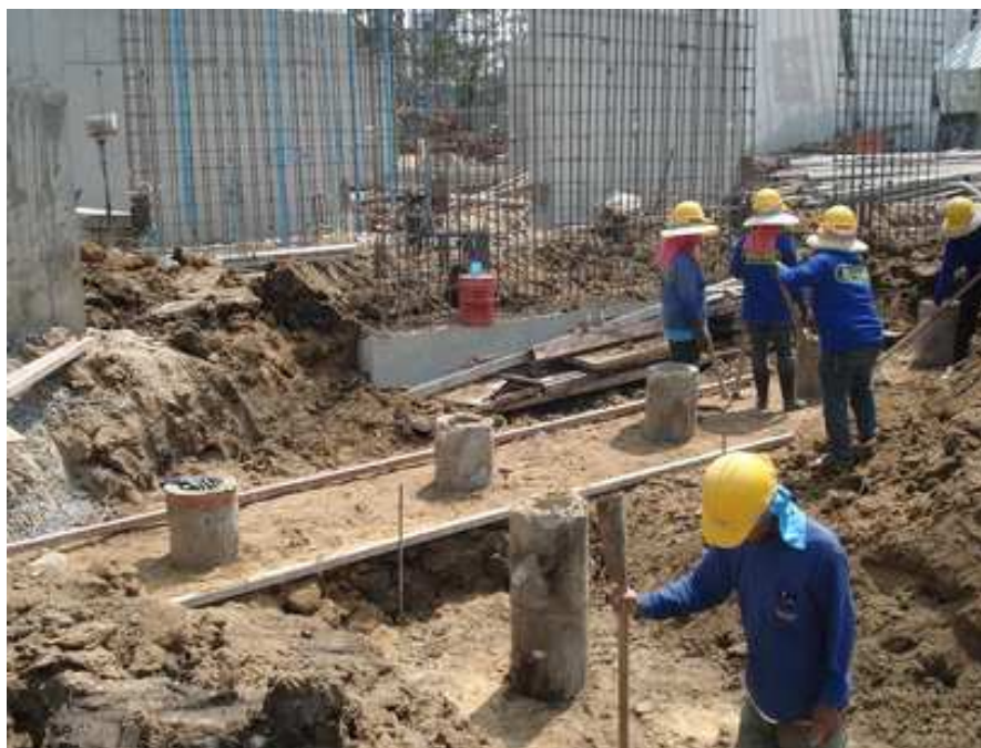
ภาพที่ 9 งานก่อสร้างฐานรากภายในโครงการ
