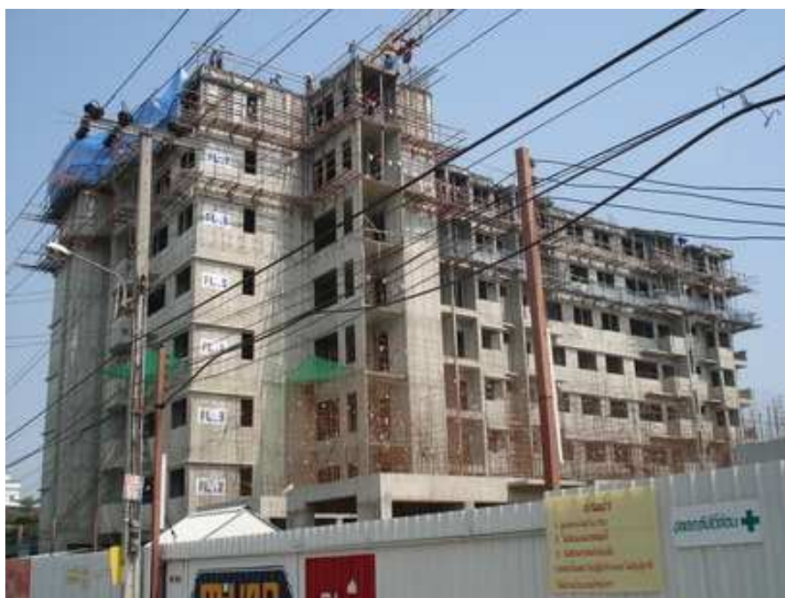
ภาพที่ 10 งานก่อสร้างโครงสร้างของโครงการ
