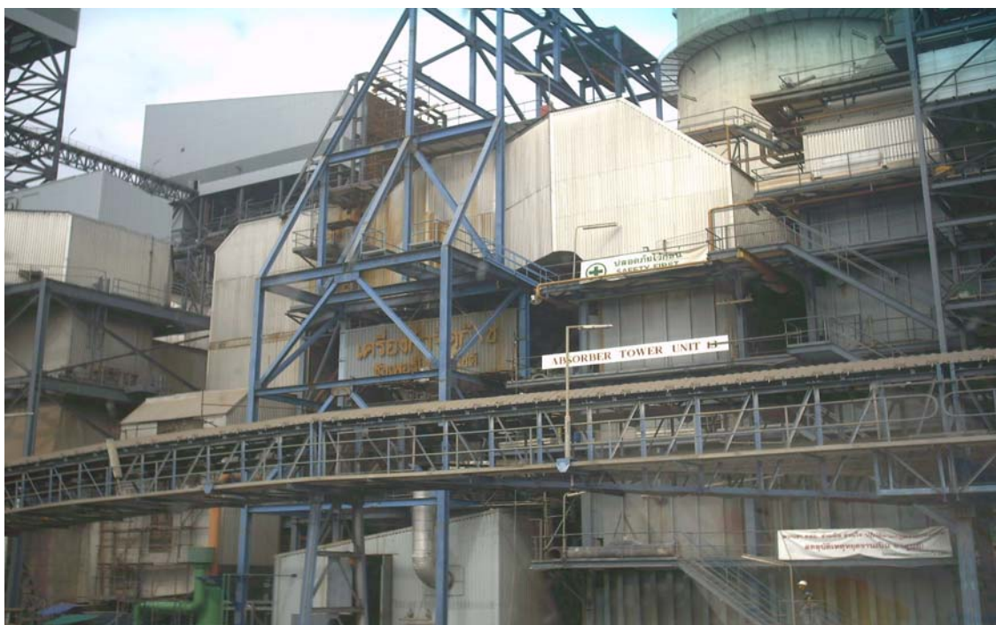
ภาพที่ 4 เครื่องกำจัดก๊าซซัลเฟอร์ไดออกไซด์ของโรงไฟฟ้าแม่เมาะ
