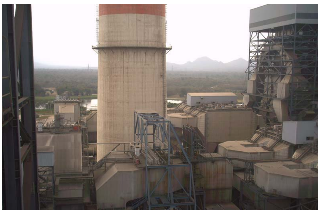
ภาพที่ 3 เครื่องกำจัดก๊าซซัลเฟอร์ไดออกไซด์ของโรงไฟฟ้าแม่เมาะ
