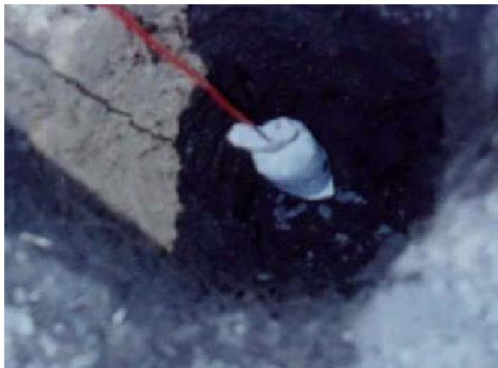
รูปที่ 5.17 แอโนดชนิดแมกนีเซียมที่ใช้กับชุดป้องกันการผุกร่อนของท่อโลหะแบบ Impressed Current
