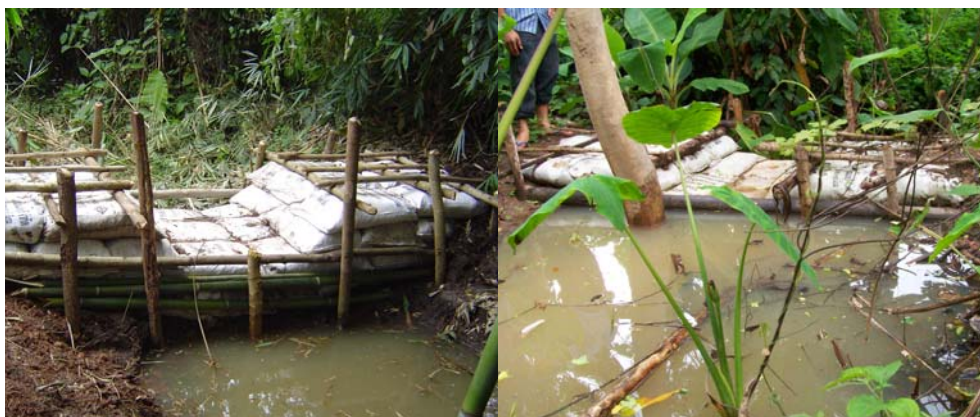
ภาพที่ 22 การทำฝายแบบผสมผสาน พื้นที่ลุ่มน้ำคู่ ต.เลยวังไสย์ อ.ภูหลวง จ.เลย
