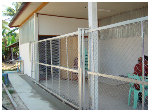
ภาพที่ 4.2.1 บริเวณโรงงานก่อนการปรับปรุง (สิงหาคม 2554)
