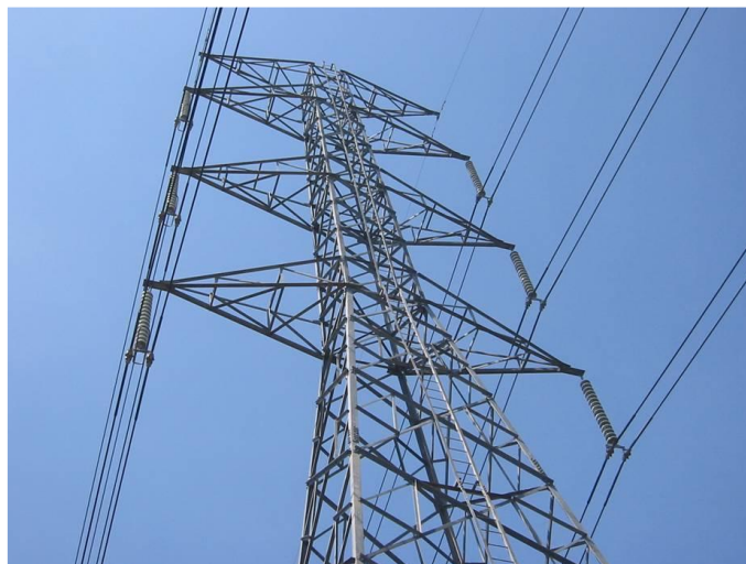
ภาพที่ 36 เสาโครงเหล็กทงวงจรคู่
