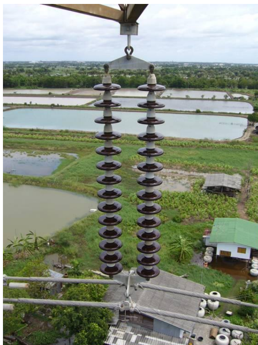
ภาพที่ 39 ชุดลูกถ้วยแบบแขวนคู่
