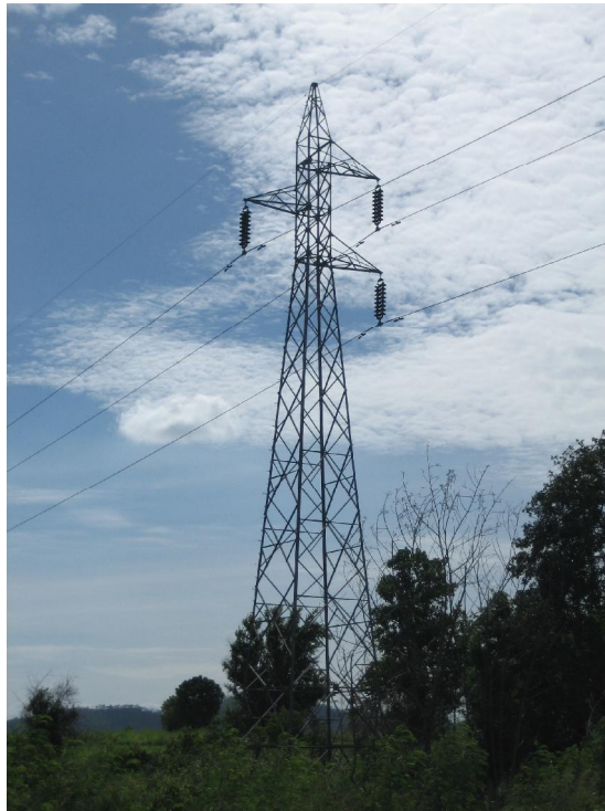
ภาพที่ 35 เสาโครงเหล็กแบบวงจรเดียว
