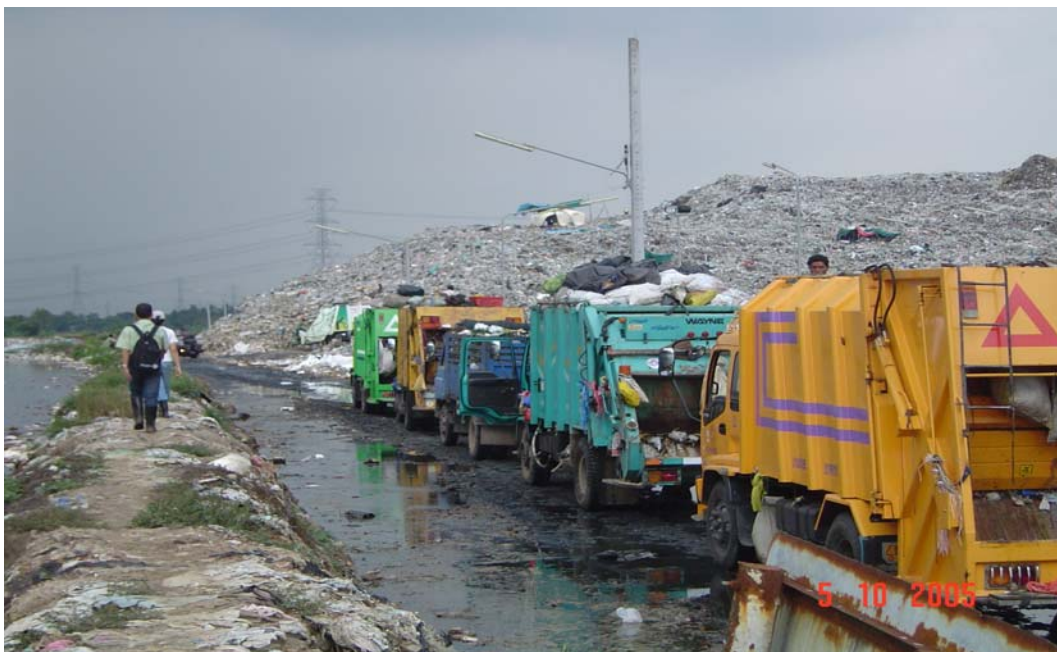
ภาพที่ 14 ถนนและคันดินโดยรอบบริเวณสถานที่กำจัดมูลฝอย (พฤษภาคม พ.ศ. 2548)
