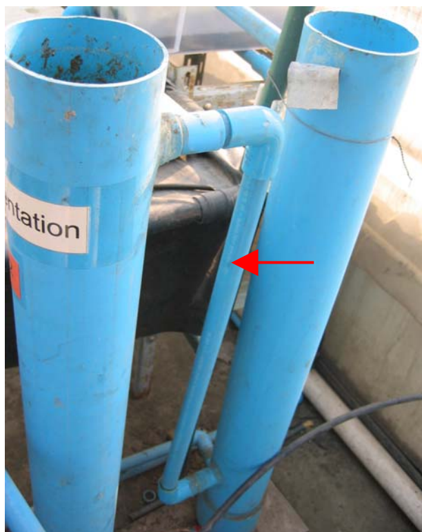
ภาพที่ 4.15 บริเวณท่อ PVC เชื่อมระหว่างถังตกตะกอนทั้ง 2 ถัง
