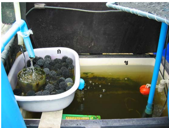
ภาพที่ 3.3 ถังกรองชีวภาพ (ก) และถังเก็บน้ำ (ข)
