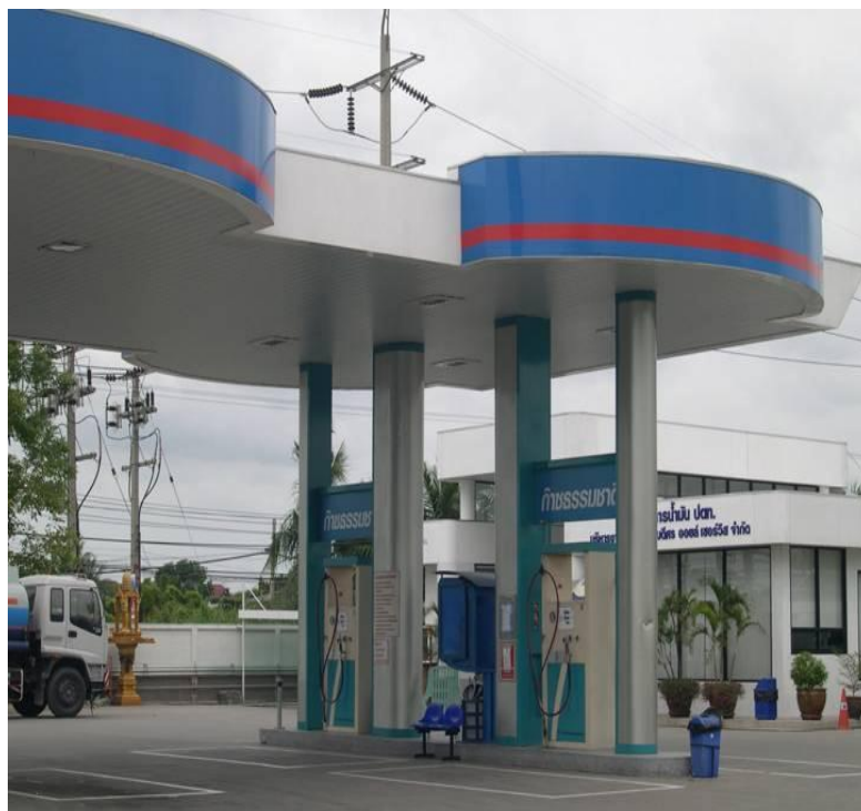
รูปที่ 5.2.18 สถานีเดิมเชื้อเพลิงปีโตเลียมหน้านิคมอุตสาหกรรมลาดกระบัง
