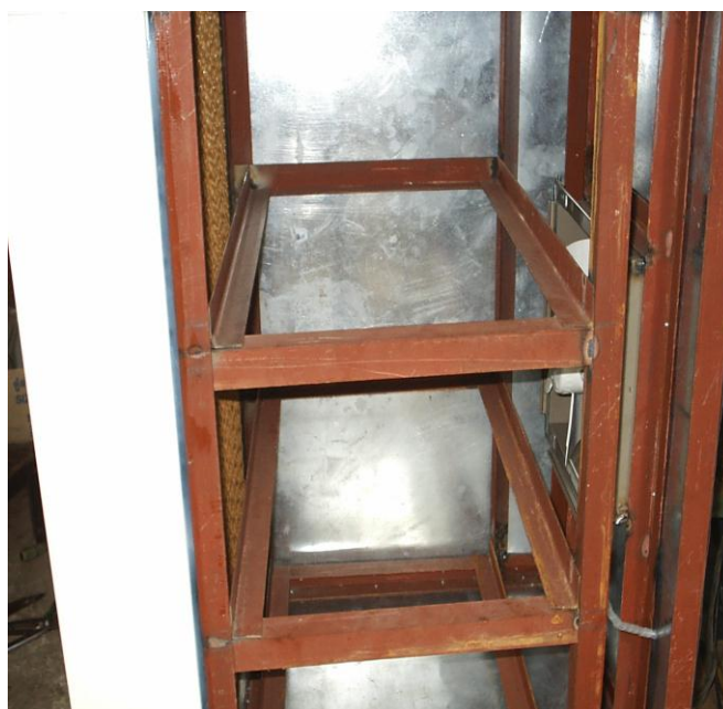
รูปที่ 4.5 โครงเหล็ก
