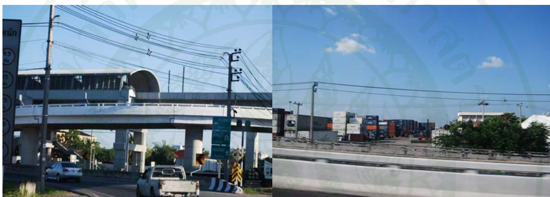
ภาพที่ 4.10 สถานีรถไฟฟ้าแอร์พอร์ตลิงค์และศูนย์บรรจุหีบห่อของการรถไฟแห่งประเทศไทย
