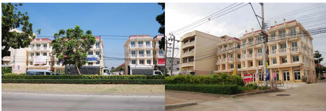
ภาพที่ 4.9 อาคารพาณิชย์กรรมก่อสร้างใหม่ตั้งกระจายตามแนวถนนในเขตทวีวัฒนา
