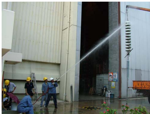
รูปที่ 3.2 การล้างลูกถ้วยฉนวนกระแสดรที่มีการจับเกาะของสิ่งเปราะเปื้อน
