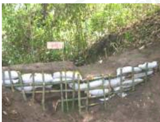
ภาพที่ 4.5 การก่อสร้างฝายชะลอน้ำในพื้นที่ลุ่มน้ำแม่สา จังหวัดเชียงใหม่ ที่มา: องค์การบริหารส่วนตำบลโป่งแยง (2553)
