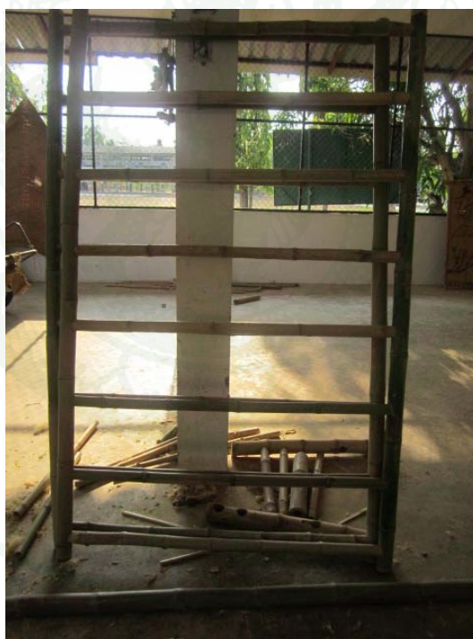
ภาพผนวกที่ 13 การประกอบเป็นโครงสร้าง ที่มา: จากการสำรวจ
