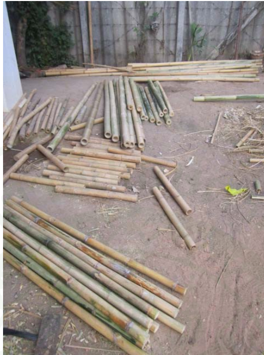
ภาพผนวกที่ 10 การตัดไม้เตรียมไว้ตามขนาดที่ต้องการ ที่มา: จากการสำรวจ
