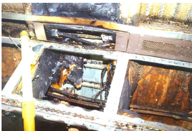
ภาพที่ 3 การเกิดเหตุเพลิงไหม้ขึ้นที่บริเวณด้านใต้ห้องเก็บสินค้า (Hidden Area)
