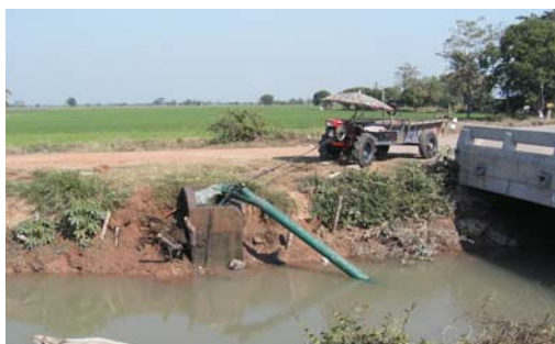
การติดตั้งเครื่องสูบน้ำในช่วงแล้ง
