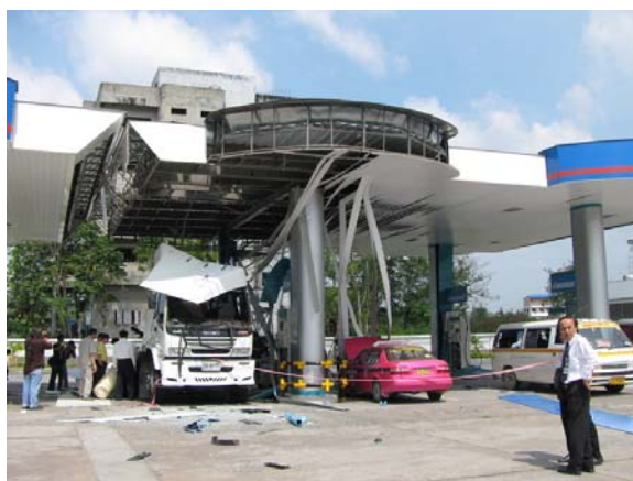
ภาพที่ 16 ถังระเบิดขณะเติมก๊าซ
