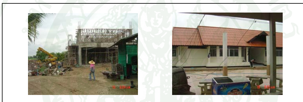
ภาพที่ 33 อาคารใหม่ที่กำลังก่อสร้าง 2 หลังโดยได้รับงบประมาณจากเทศบาล ที่มา: ภาพจากแฟ้มของโรงเรียน
