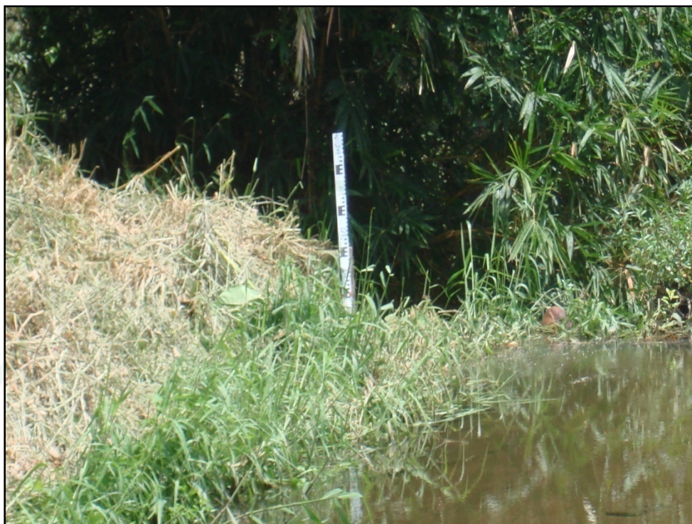
ภาพผนวกที่ ข1 การติดตั้งแผ่นวัดระดับน้ำที่ฝายทุ่งนากลาง
