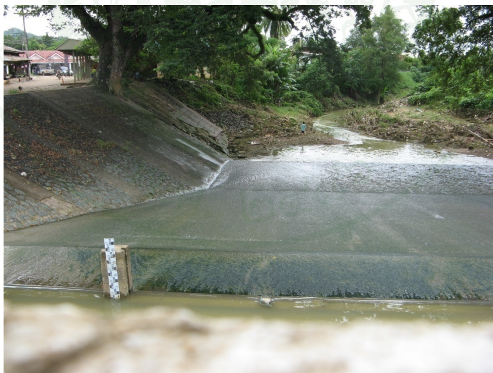
ภาพผนวกที่ ข4 การติดตั้งแผ่นวัดระดับน้ำที่ฝายหลวง
