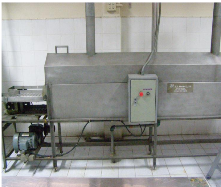
ภาพผนวกที่ 1 เครื่องไล่อากาศ (Exhauster)
